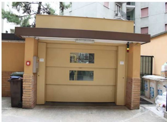
Foto n. 27. Cortile interno condominiale al piano S1. Ingresso parcheggio meccanizzato "Hiko Park"
