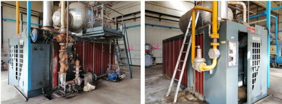
Locale caldaia: Caldaia vapore Kessel 3 ton - Caldaia olio Therma con evaporatore 5 ton - Impianto addolcimento acqua - Serbatoi stoccaggio –
