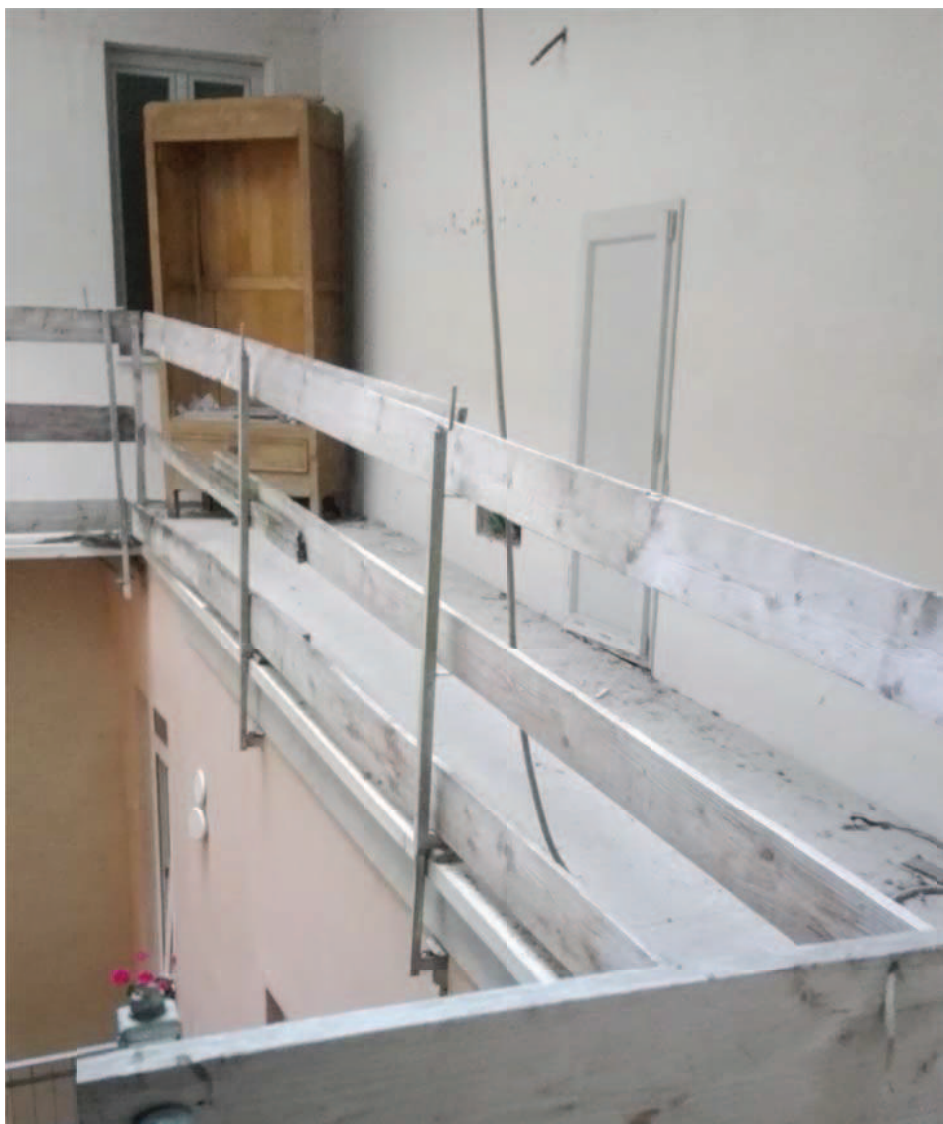
Ballatoio corte interna: mancato i parapetti e le finiture dei ballatoi
