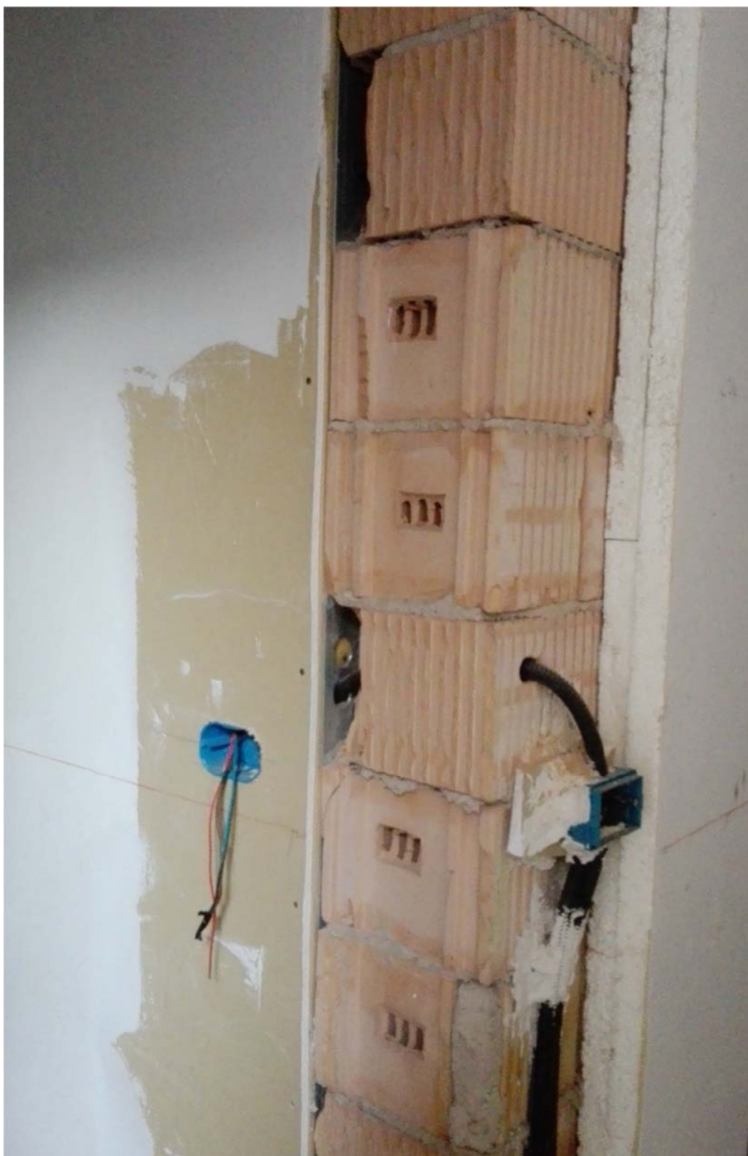
Appartamenti non ultimati
