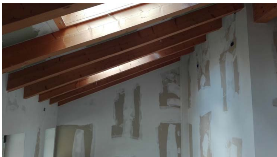
Appartamenti non ultimati
