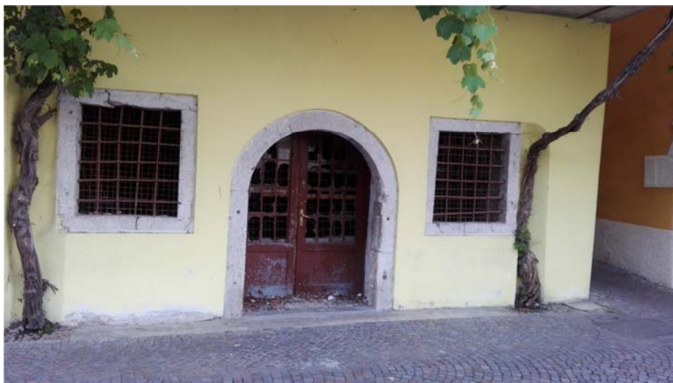
Ingresso da lato sud a cantina piano terra
