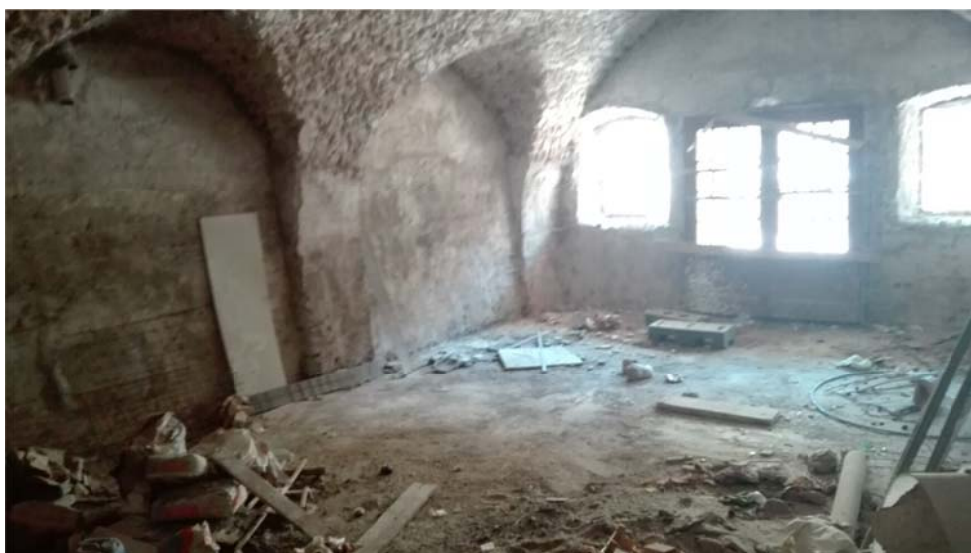
Cantina a piano terra (si noti lo stato completamente a grezzo) con un accesso esterno e un accesso da corte interna
