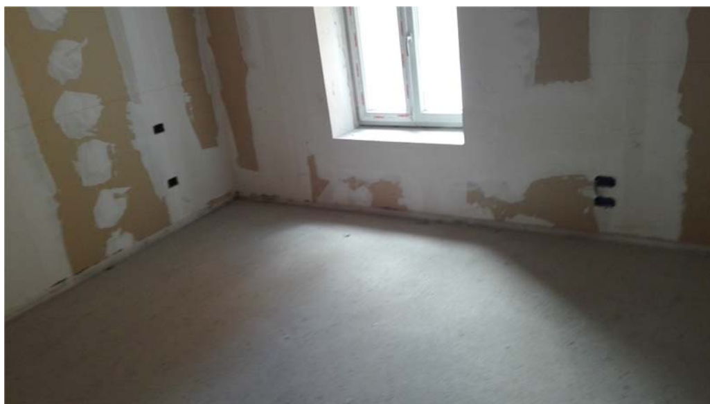
Appartamenti non ultimati
