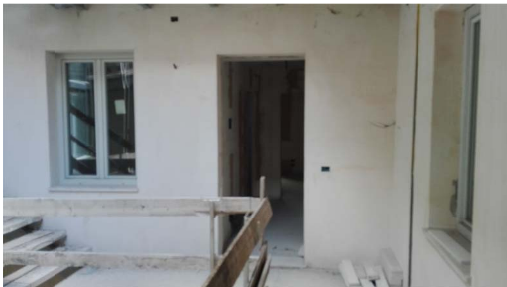
Ingresso appartamenti da ballatoio: mancato i serramenti di ingresso e i parapetti e finiture dei ballatoi
