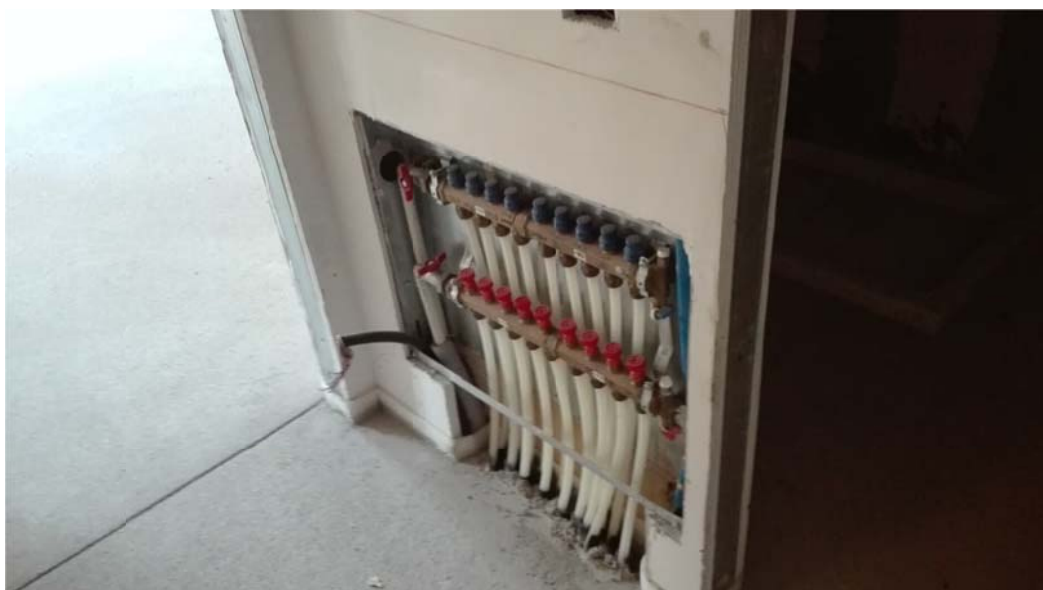
Appartamenti non ultimati
