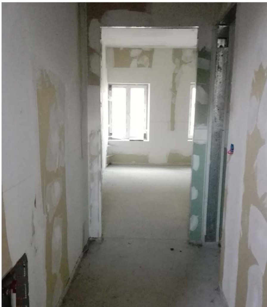
Appartamenti non ultimati
