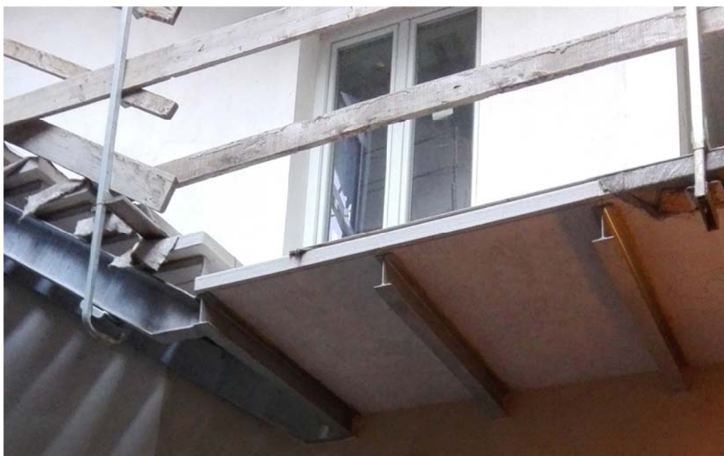
Ballatoi e scale corte interna: si è riscontrata carenza nel sistema statico strutturale
