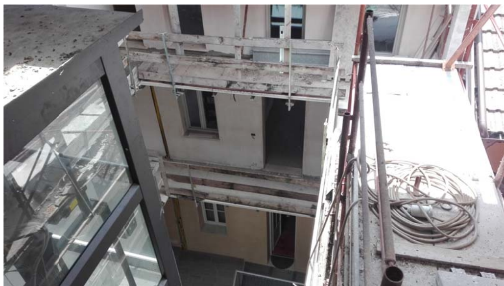
Corte interna: mancato i serramenti di ingresso e i parapetti e finiture dei ballatoi
