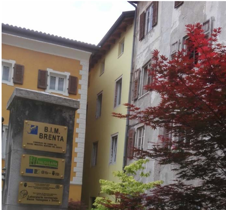
Facciata est dell'edificio p.ed. 190 (di colore giallo) con affaccio su stretto vicolo
