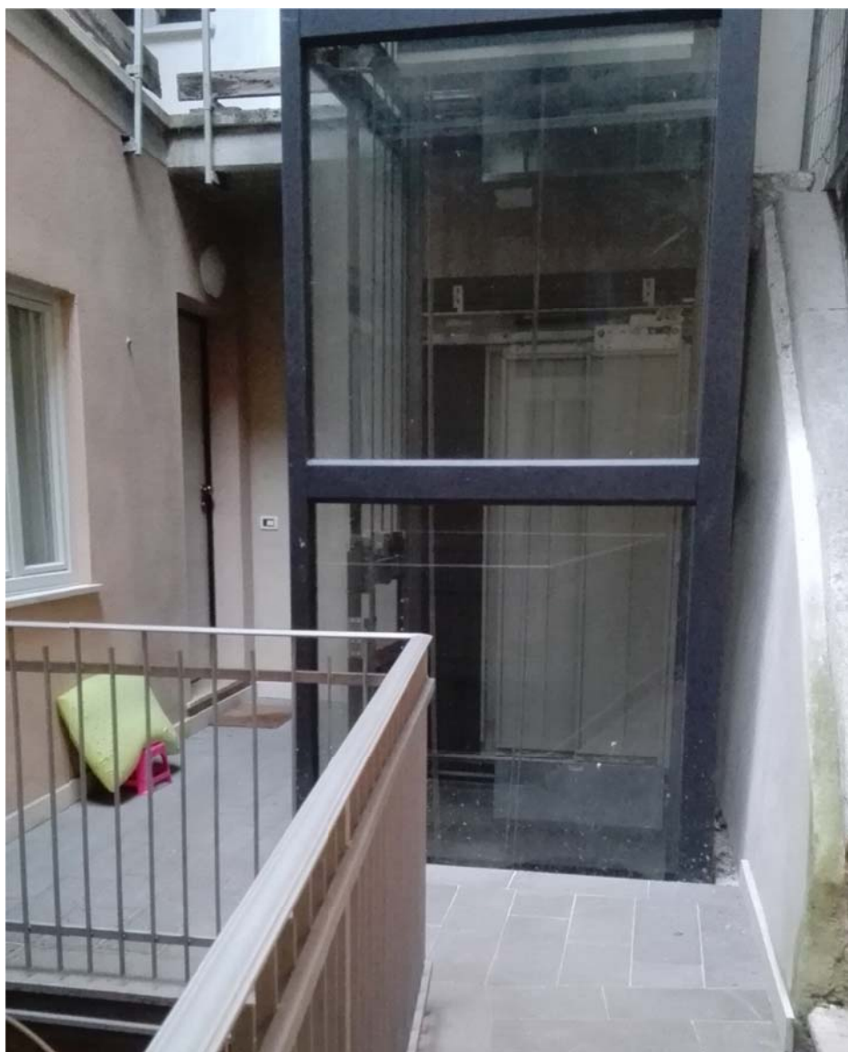
Parti comuni modificate (manca l'intavolazione) a seguito della realizzazione del vano ascensore
