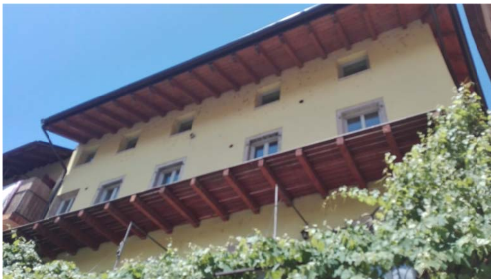
Facciata lato sud non ultimata (manca il parapetto del balcone)
