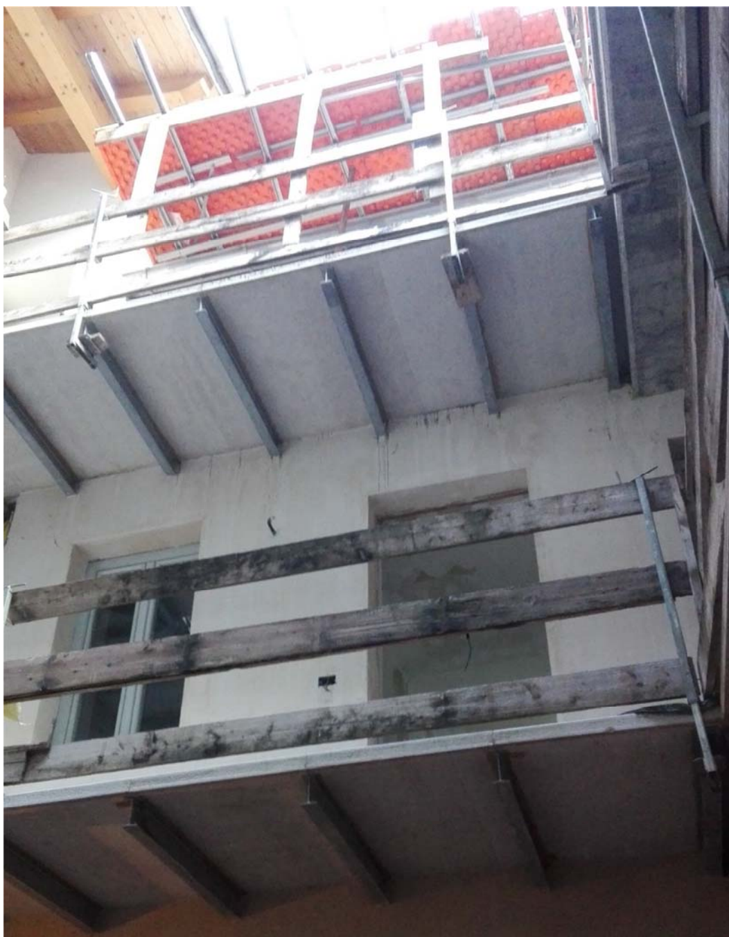
Ballatoi e scale corte interna: si è riscontrata carenza nel sistema statico strutturale
