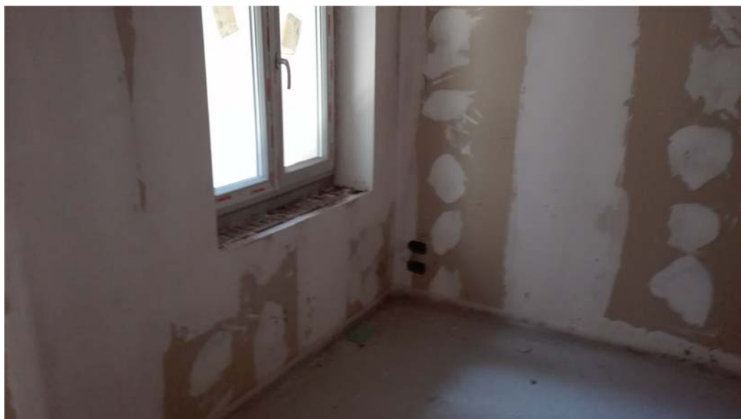
Appartamenti non ultimati
