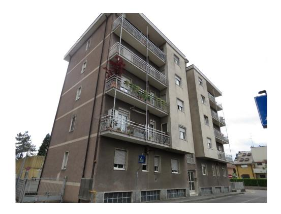
Da quanto riferito dal Comune di Limbiate la costruzione è stata avviata a seguito di pratica edilizia del 31-3-1966 (P.E. n. 138/66) con sistema costruttivo tipico dell'epoca in struttura intelaiata in calcestruzzo armato con orizzonti in latero-cemento e paramenti in laterizio.
