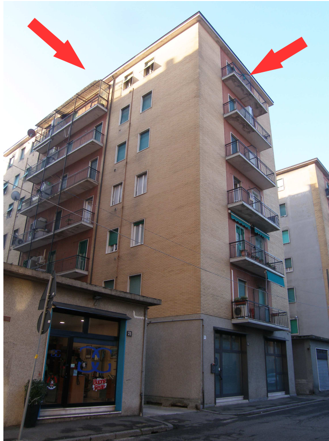
vista edificio su Lombardia 23
