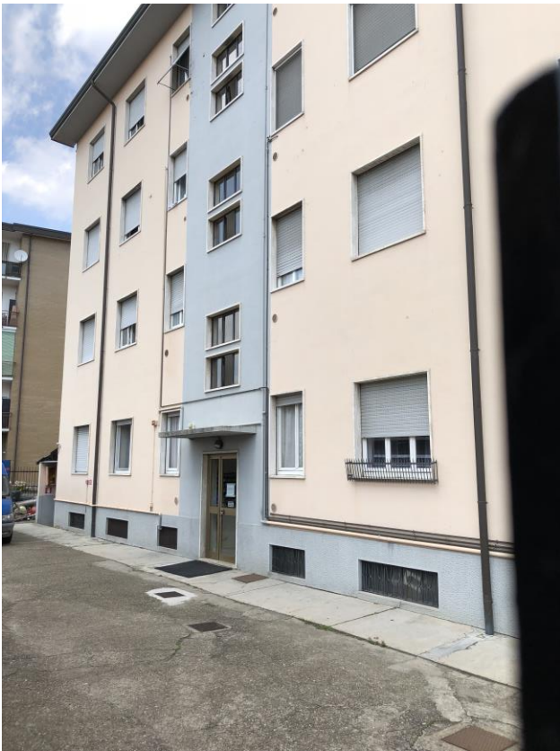
Vista del fabbricato dal cortile interno
