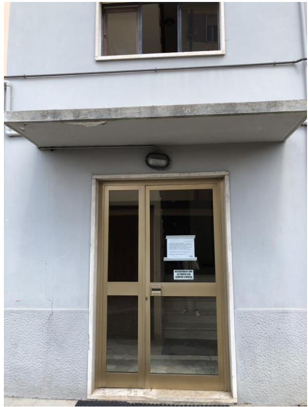
Vista portone ingresso allo stabile
