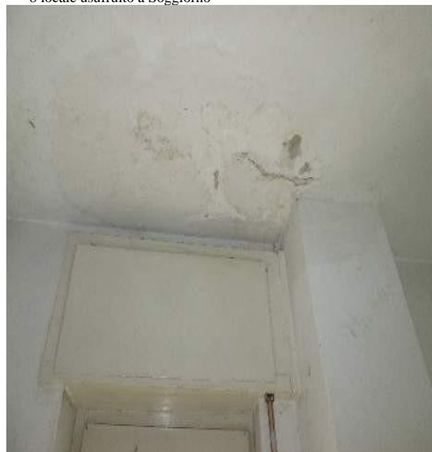
10 Infiltrazione solaio bagno
