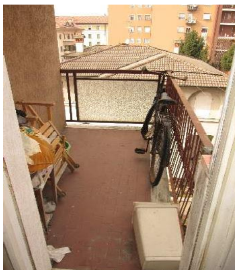
14 unico balcone ispezionabile lato cortile
