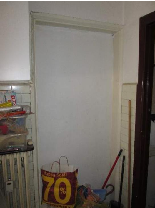
7 Tamponamento porta collegamento cucina/sogg.
