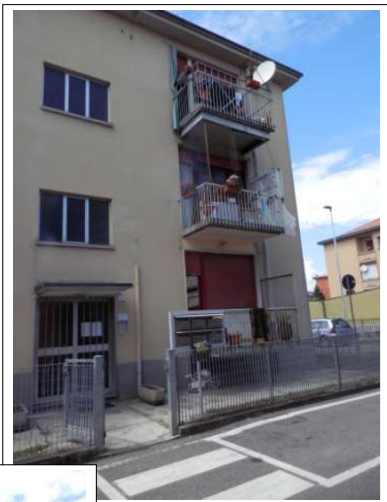
Fotografia n°1 – Vista della facciata del fabbricato.
