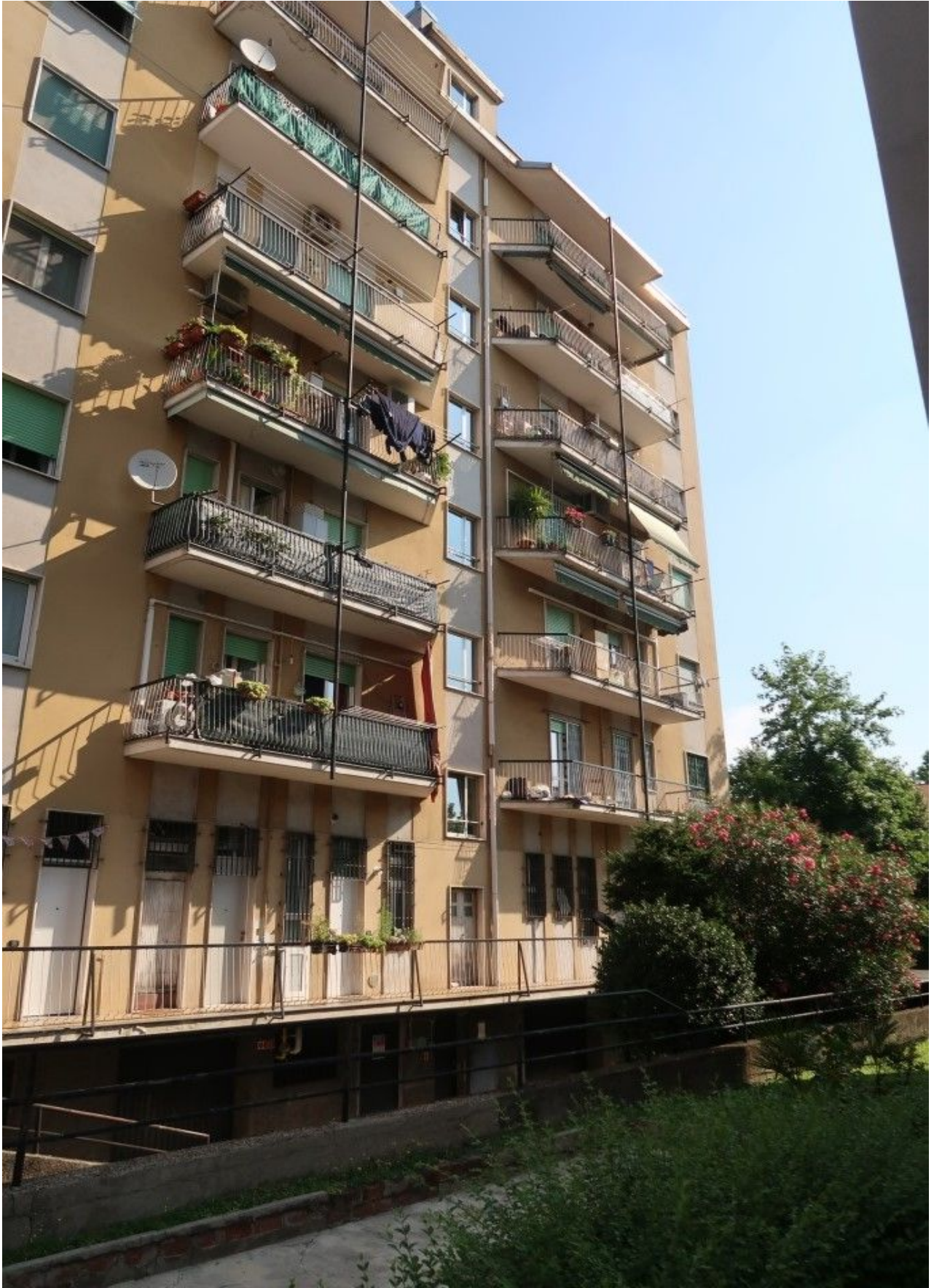
FACCIATA SU CORTILE INTERNO
