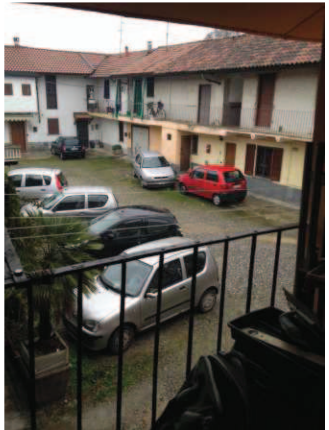
Balcone che si affaccia sulla corte interna
