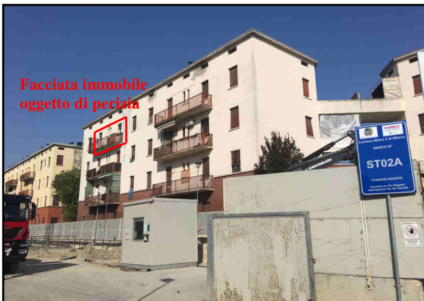
Foto facciata da via Paolo Segneri
