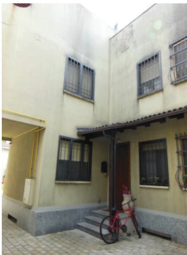
Foto 2: porta d'accesso all'appartamento
