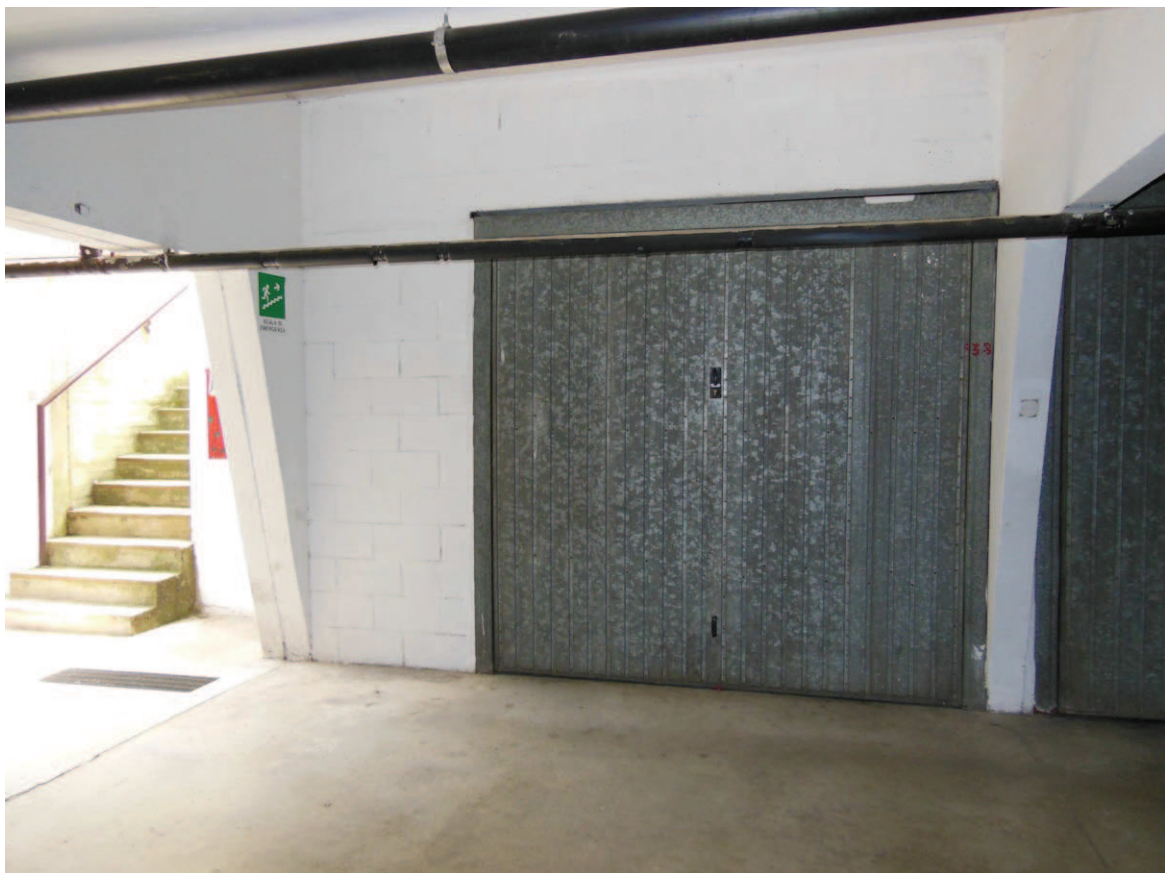
Foto 4: portone d'accesso al box autorimessa
