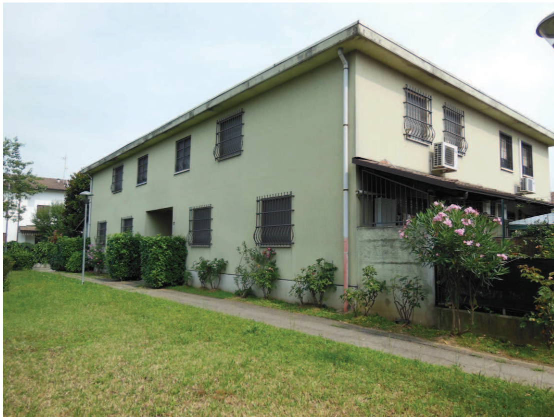
Foto 1: prospetto su Via E. Fermi
