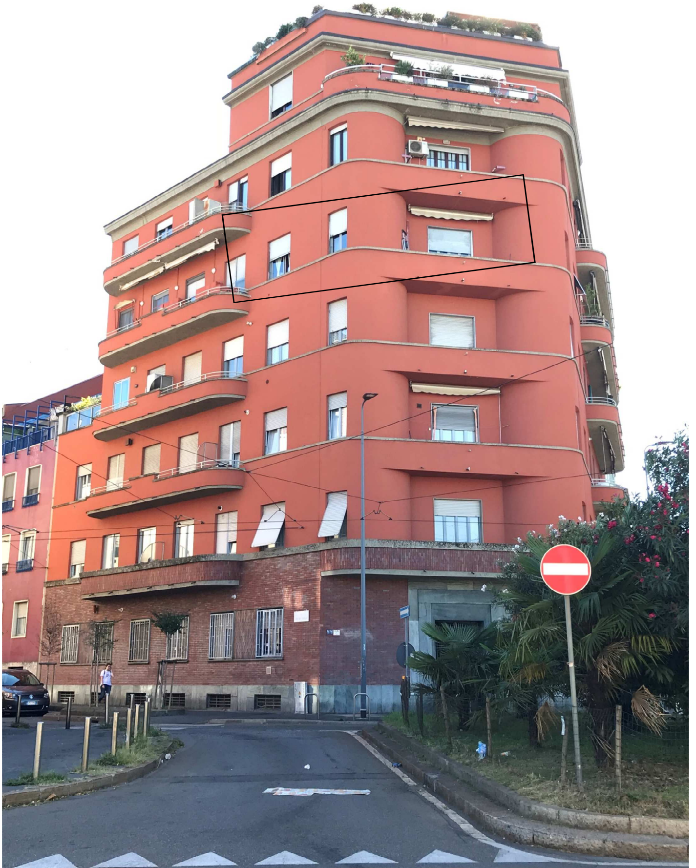
Edificio di Via Ferrante Aporti 60
