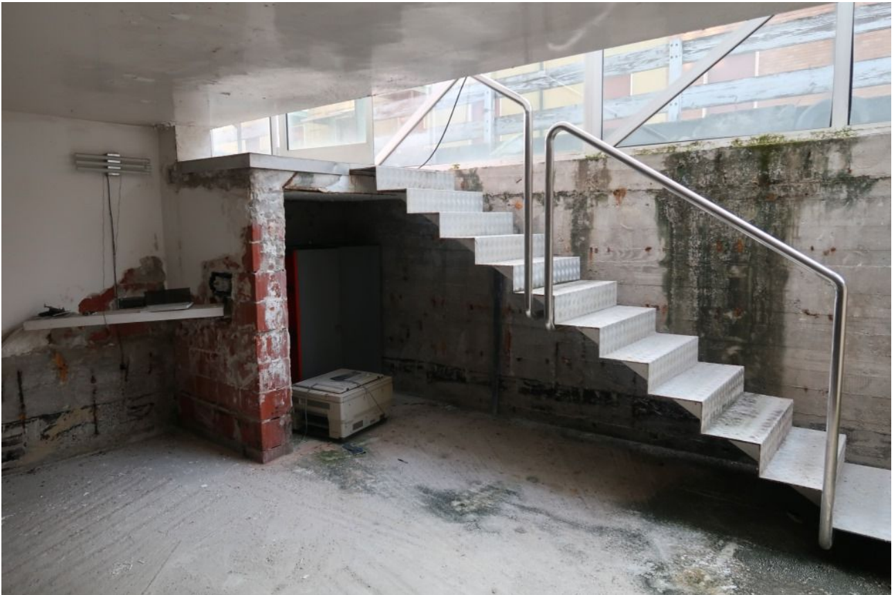
PIANO SEMINTERRATO FOTO 3
