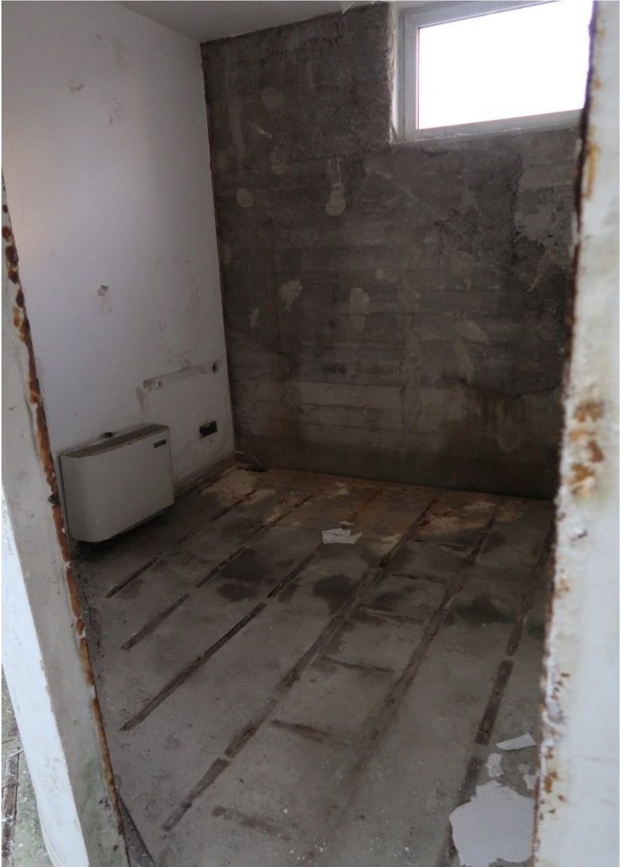
RIPOSTIGLIO PIANO SEMINTERRATO
