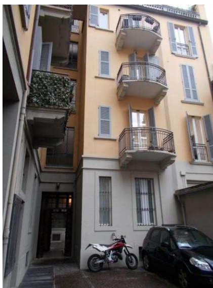
5. Facciate della corte interna
