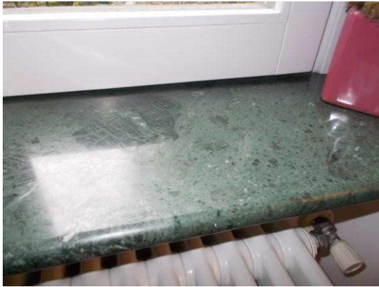
17. Dettaglio davanzale interno in marmo
