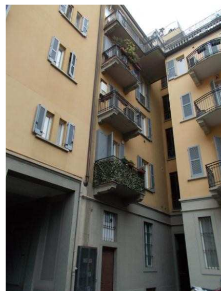
6. Facciate della corte interna
