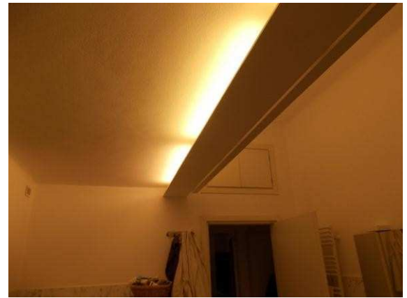
40. Particolare del sistema di illuminazione del secondo bagno
