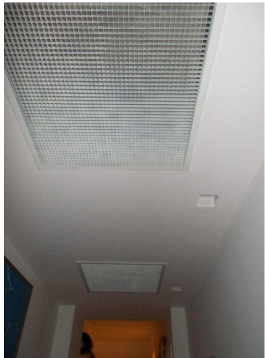
30. Griglia impianto di condizionamento
