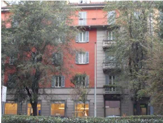
1. Facciata esterna dalla via
