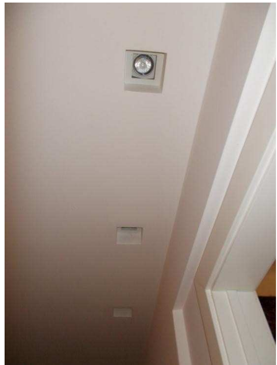
36. Illuminazione del corridoio
