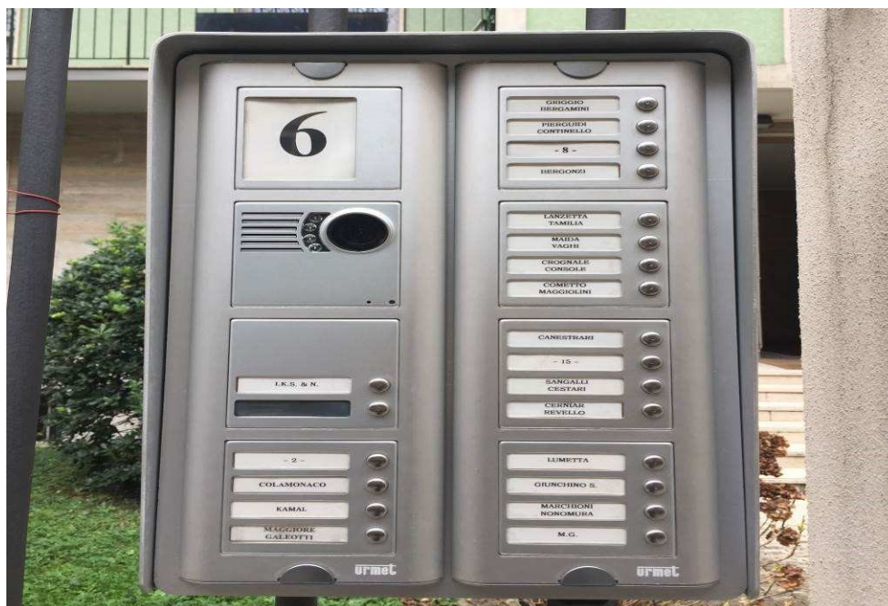
Fotografia n. 2 – Particolare del citofono posizionato in corrispondenza dell'ingresso pedonale sulla Via Meina n. 6, dove non compaiono né il nome del debitore esecutato né il nome dell'occupate l'immobile pignorato
