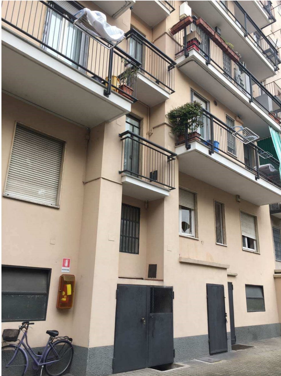
Fotografia n. 6 – Vista del prospetto secondario del Condominio Via Meina n. 6, Milano con particolare della porta di accesso al corpo scale sulla sinistra e della porta di accesso ai locali cantina sulla destra
