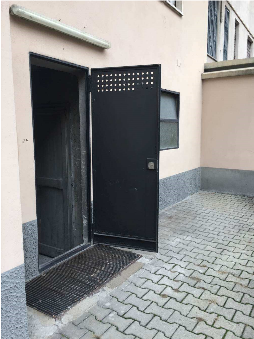
Fotografia n. 7 – Particolare della porta di accesso ai locali cantina al piano seminterrato
