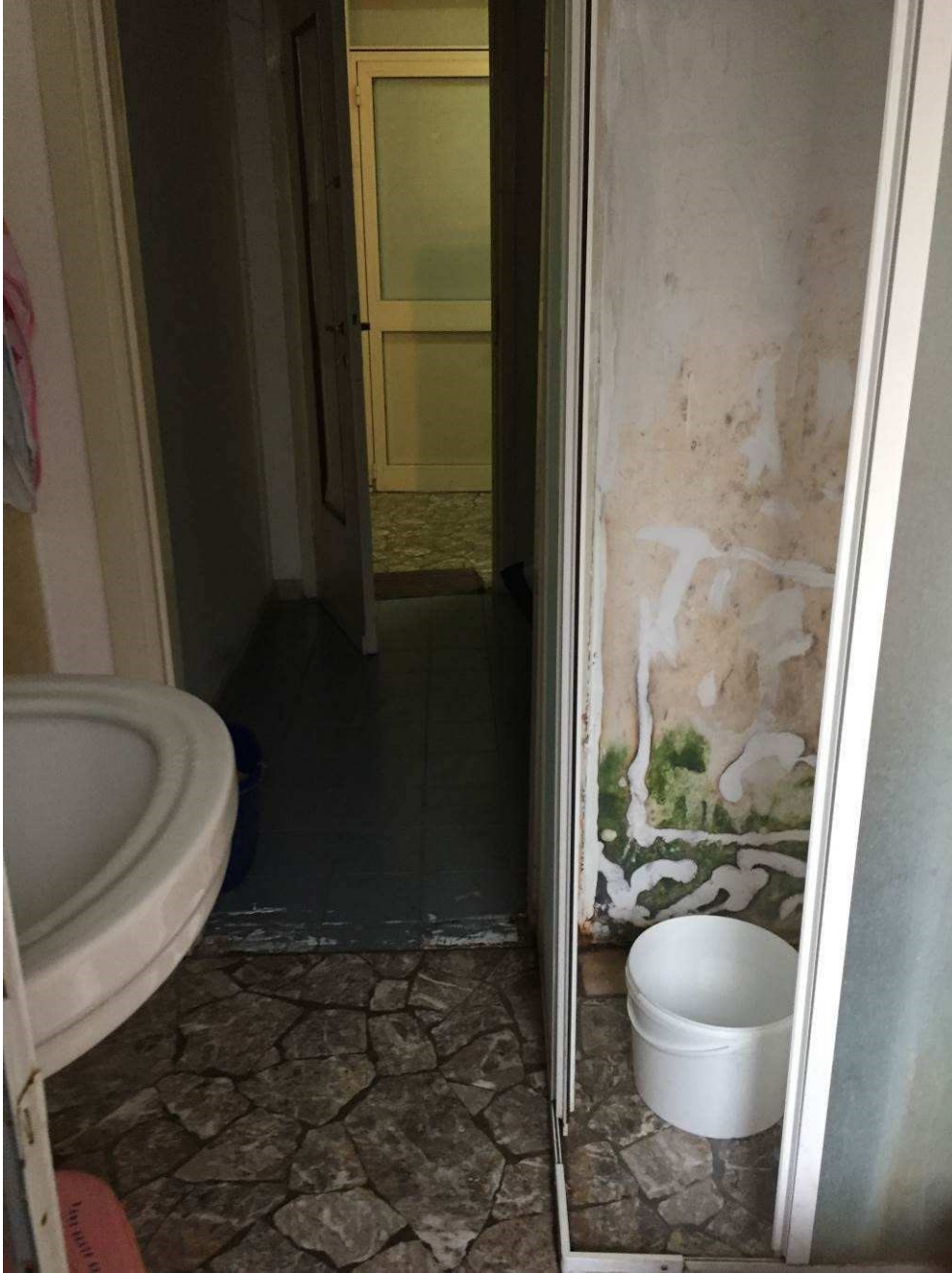
Fotografia n. 24 – Vista del locale bagno, con particolare della doccia (priva di piatto doccia e di rivestimento), e dell'accesso al locale antibagno privo della porta
