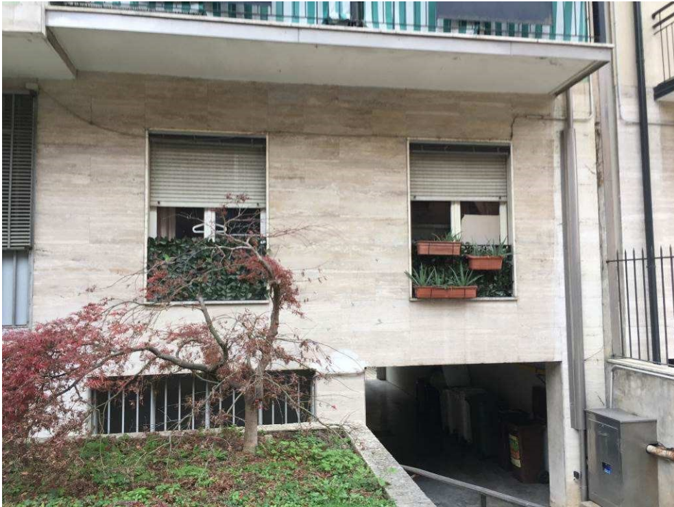
Fotografia n. 4 – Vista del prospetto principale su strada del Condominio, con particolare di due finestre (camere) dell'appartamento oggetto di pignoramento al piano rialzato, e dell'accesso a destra al cortile comune sul retro
