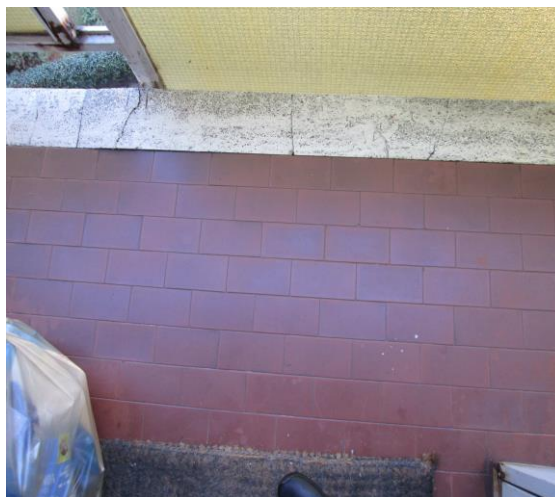
Rivestimenti a terra balconi
