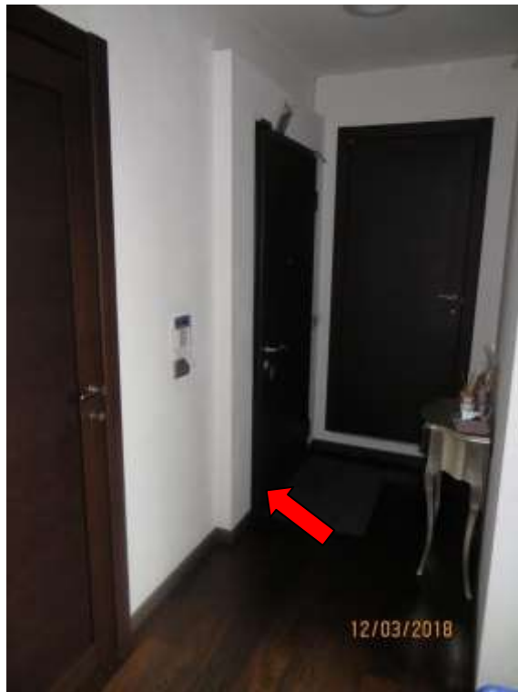
Foto 7 – Vista dell'ingresso diretto dal vano ascensore
