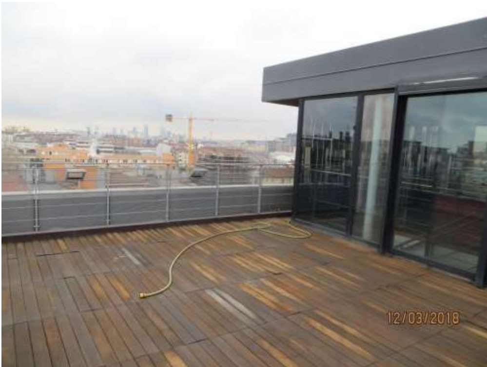
Foto 45 – Terrazzo lato Ovest
