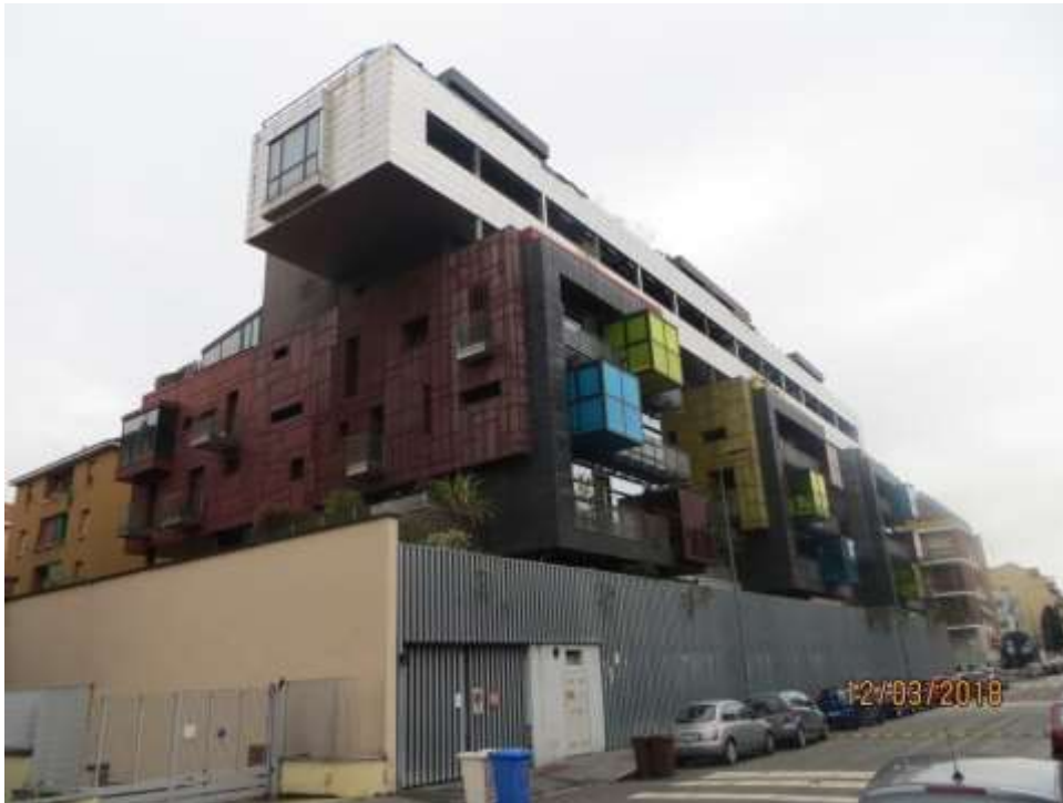
Foto 1 – Vista, da via Doberdò, del compendio immobiliare
