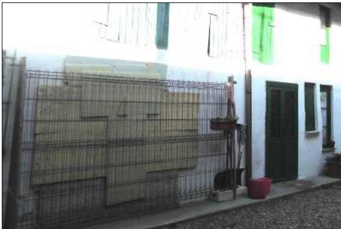
Piano terra – Wc in corpo staccato inaccessibile
