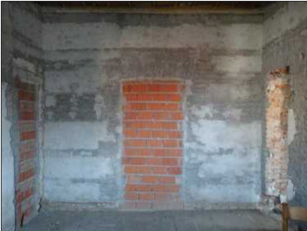
Piano primo – ingresso murato
