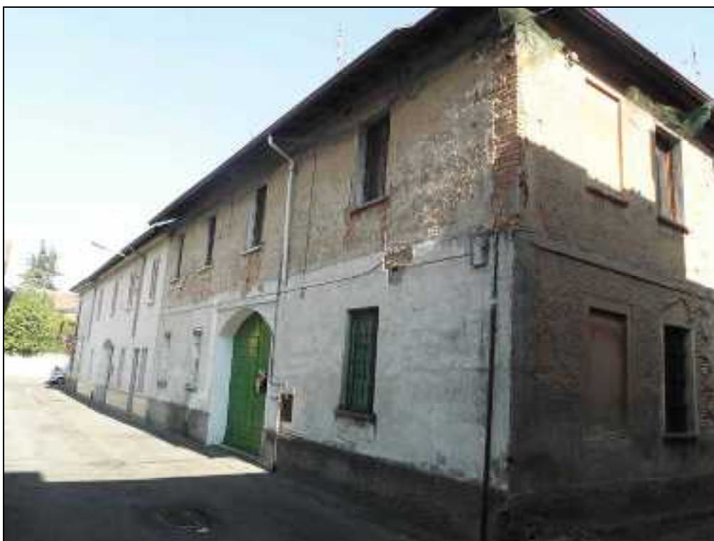
Prospetto su via Silvio Pellico
