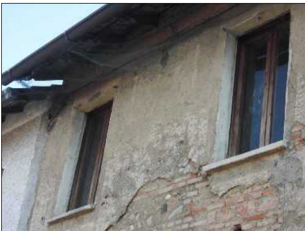
Particolare della facciata su via Silvio Pellico
