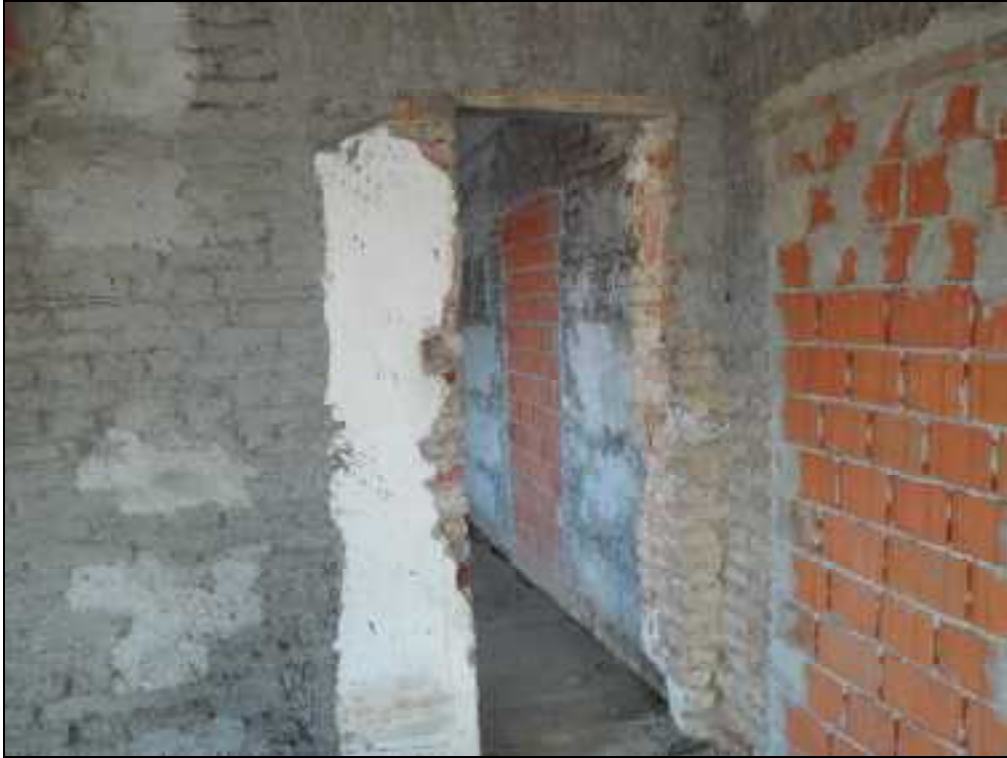
Piano primo – vano di collegamento tra i due locali
