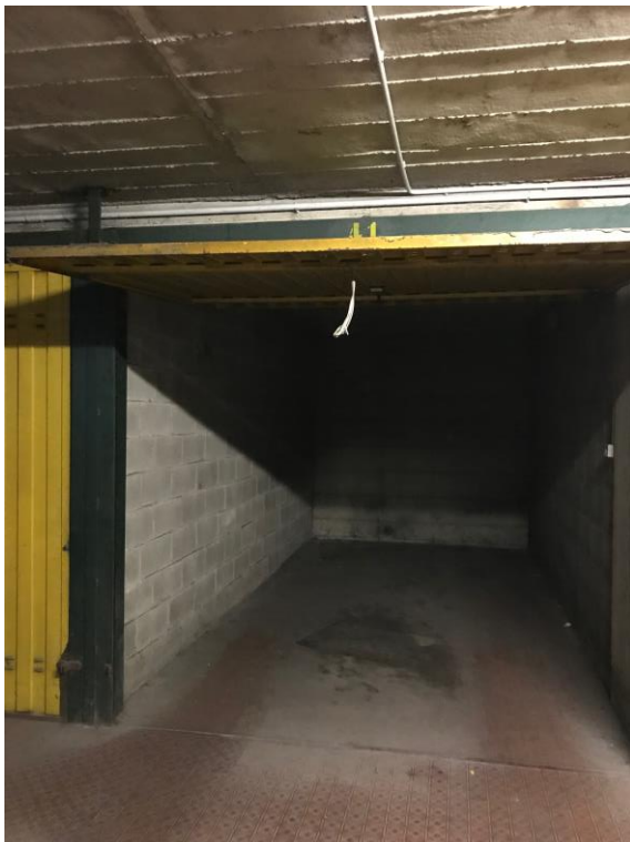
Immagine 30. L'autorimessa oggetto di valutazione.
