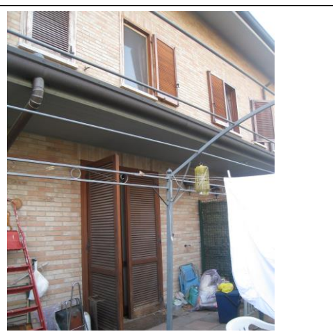
Fig. 4: edificio vista interna
