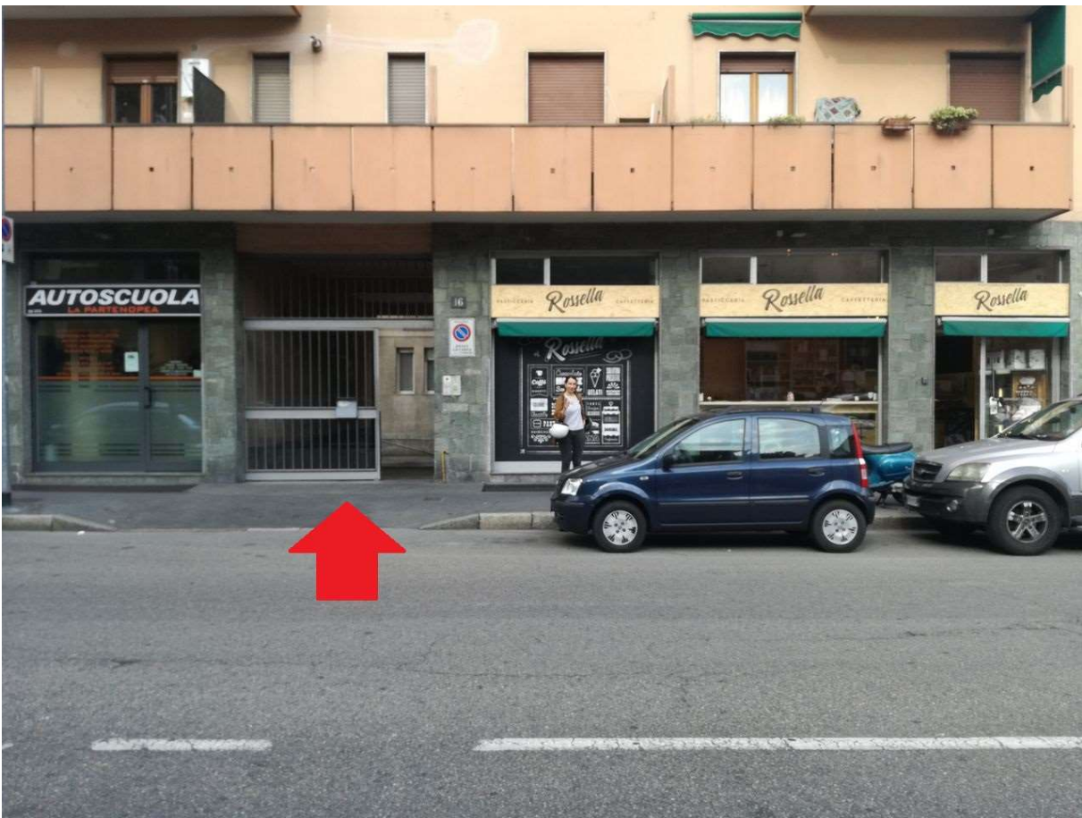
Portone di ingresso da via Adriano
