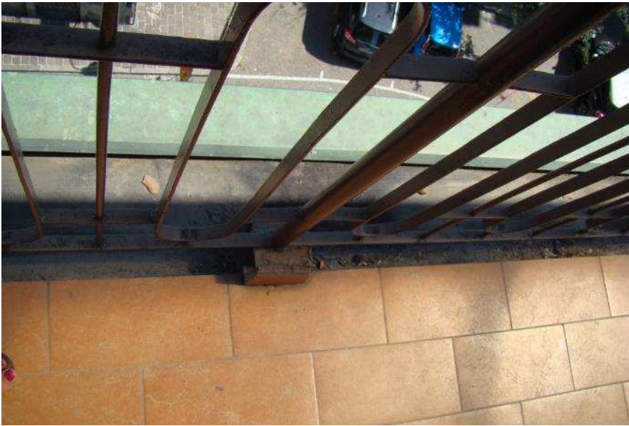
14. Dettaglio del pavimento del balcone.
