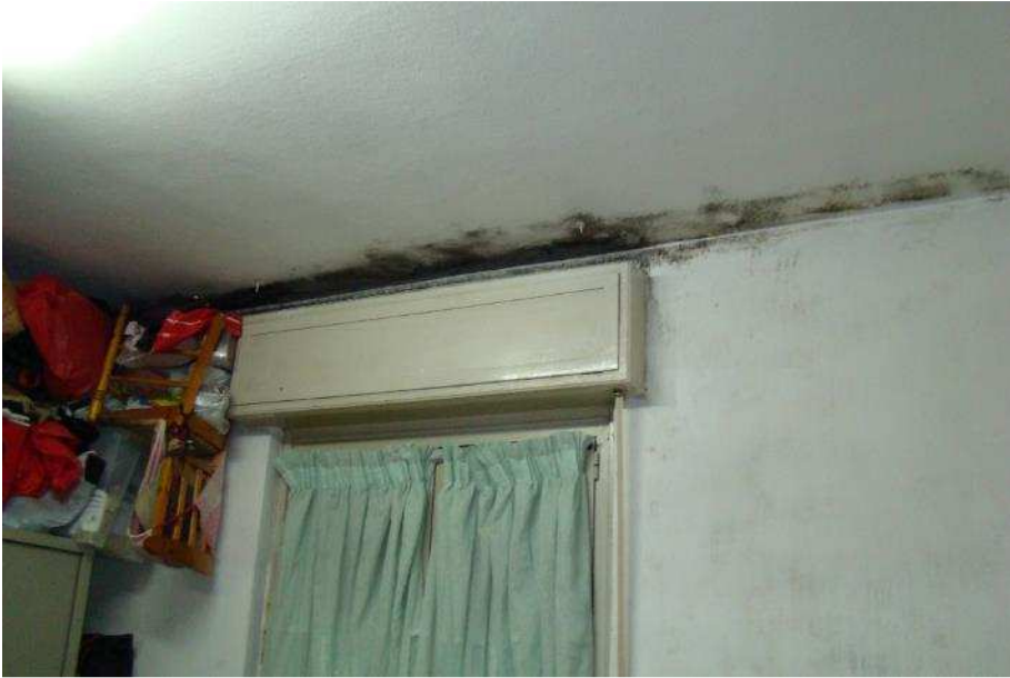
15. Dettaglio della muffa presente sul plafone della camera.
