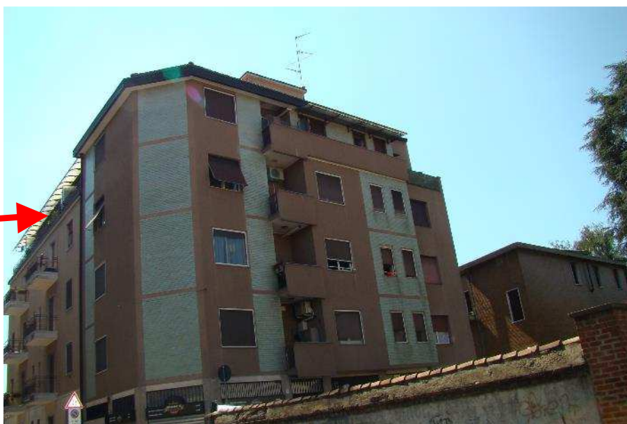
2. Vista laterale dell'edificio da via Marzoni con individuazione della pensilina del balcone.
