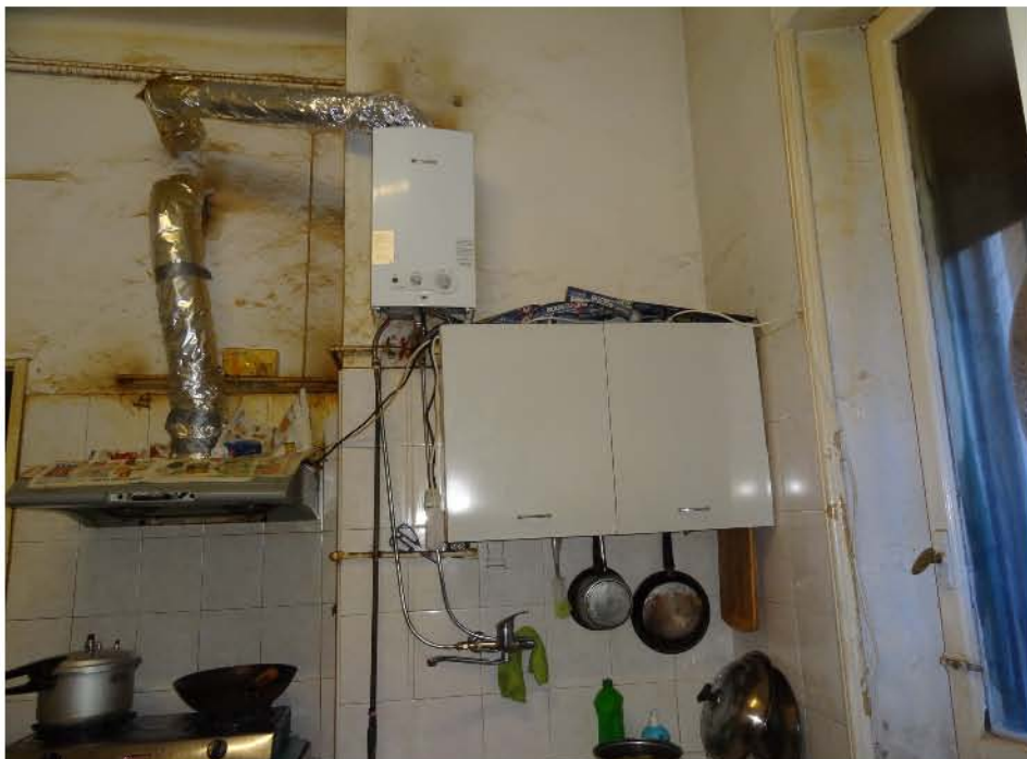
Vista interna - cucina
