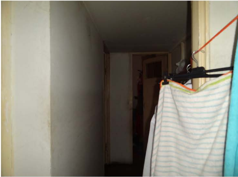
Vista interna - corridoio
