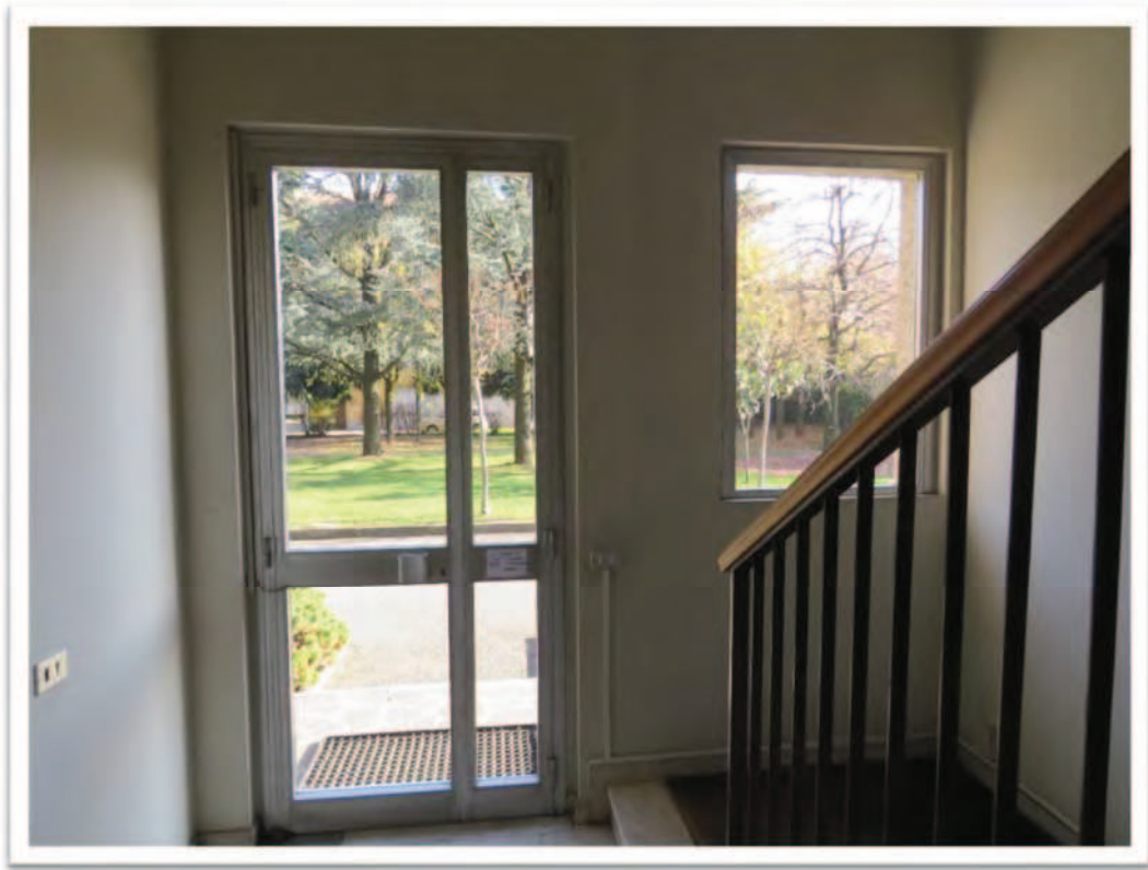
Particolare dell'ingresso condominiale e dell'ascensore ad apertura semi-automatica.
