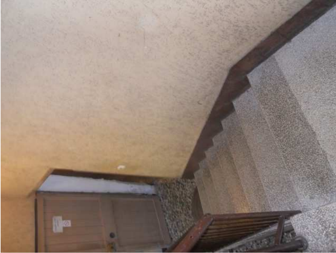
33. il tratto di scala dante accesso alle cantine
