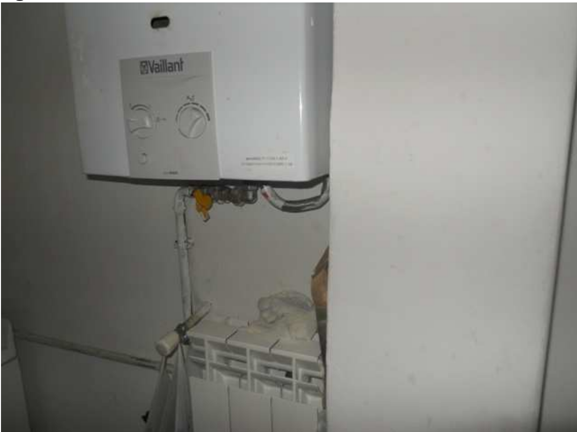
32. la caldaia istantanea a gas per la produzione di acqua calda sanitaria
