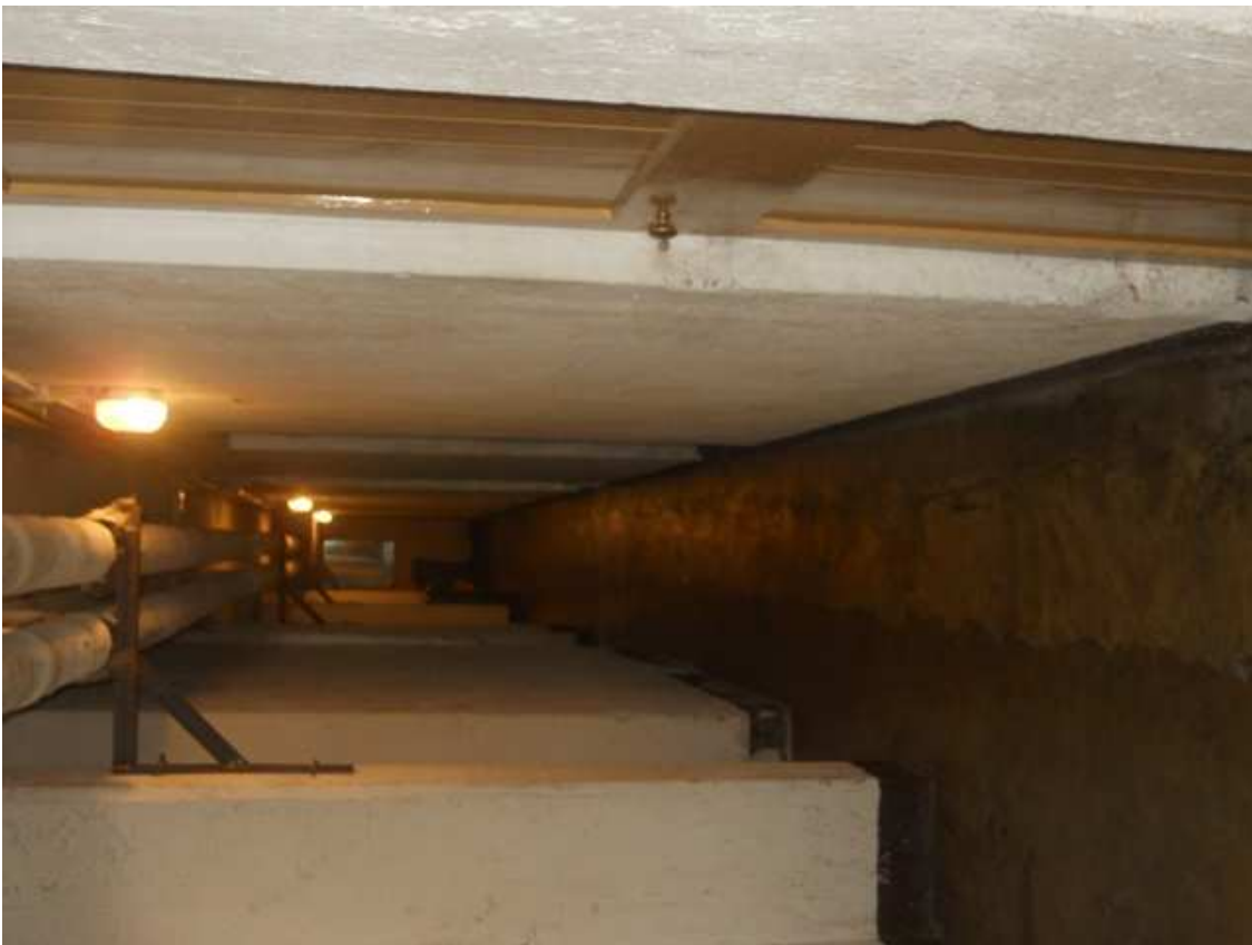
34.veduta del corridoio di accesso alle cantine
