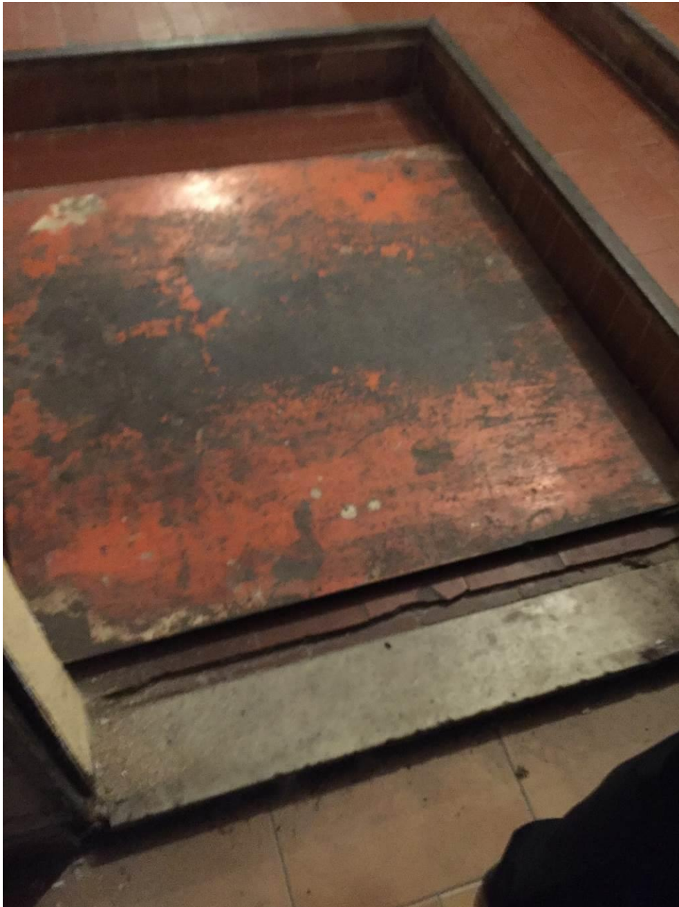
Fotografia n. 12 – Particolare dei gradini in corrispondenza dell'ingresso ai locali del laboratorio (piano seminterrato) di proprietà dell'esecutato
