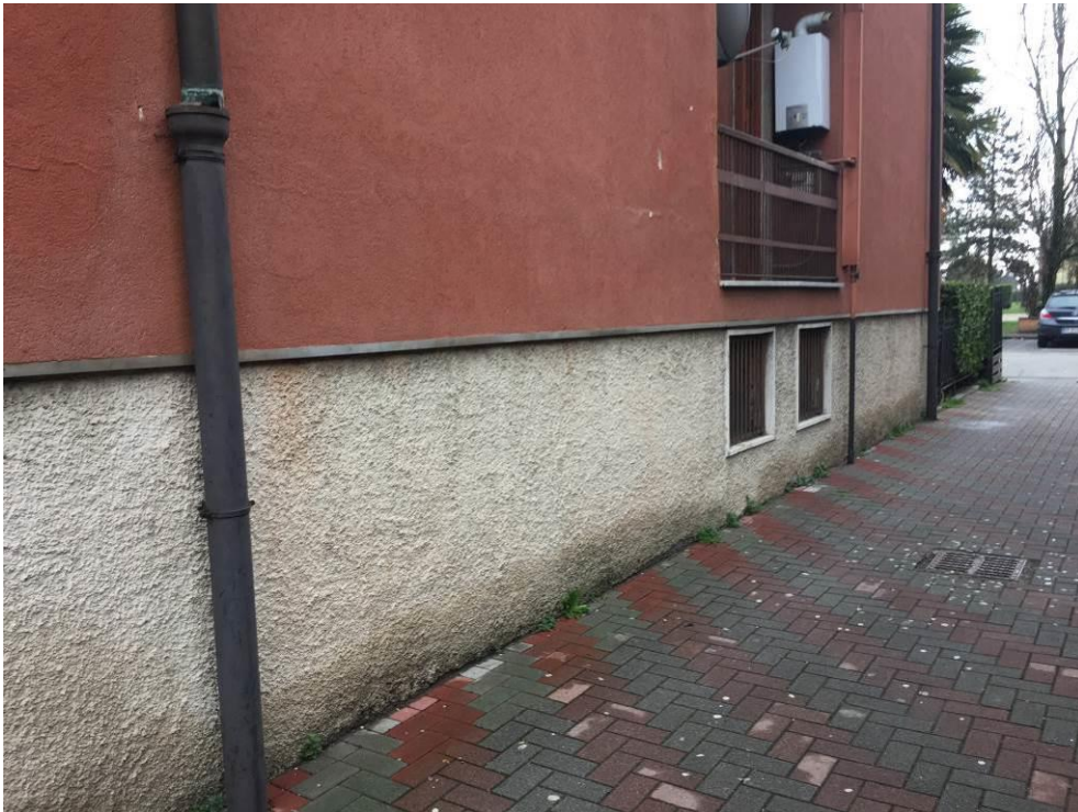
Fotografia n. 3 – Particolare dei serramenti con grata (piano seminterrato) dell'immobile di proprietà dell'esecutato - lato sud che affacciano sul percorso carraio
