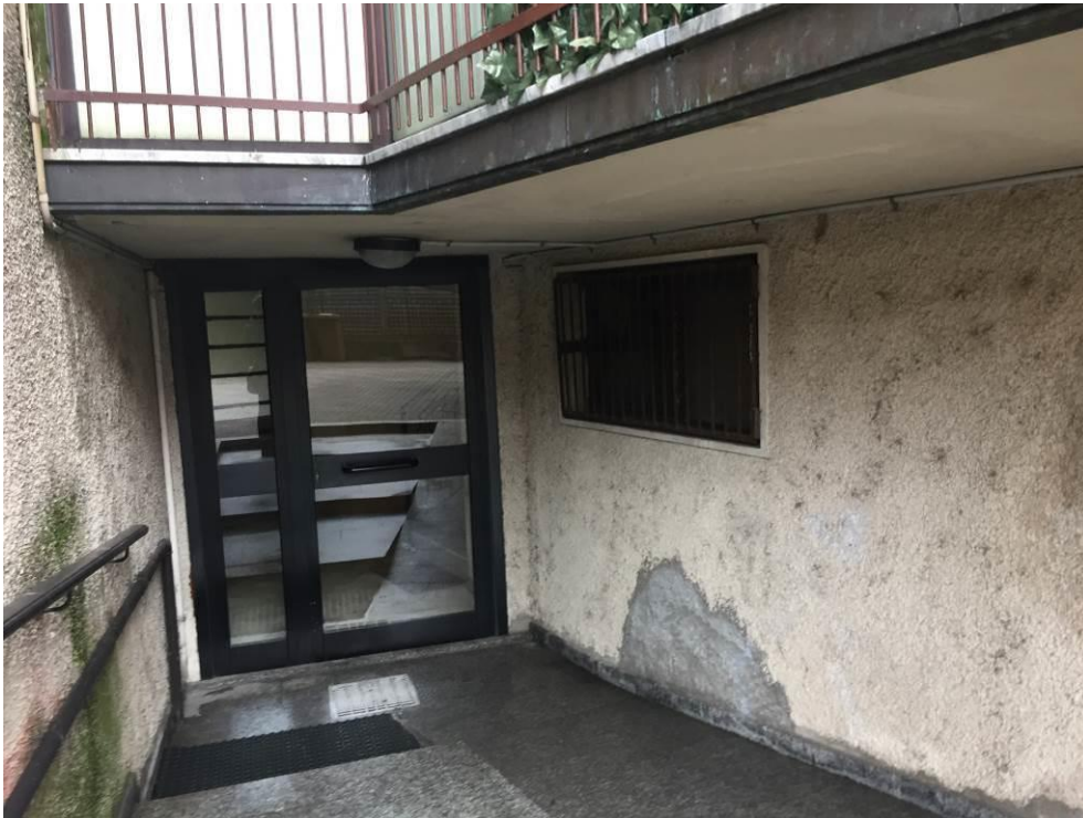
Fotografia n. 5 – Particolare del portone di ingresso al piano seminterrato del fabbricato, dove si trovano i beni immobili di proprietà dell'esecutato
