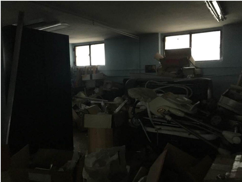
Fotografia n. 20 – Vista del laboratorio – lato ovest con serramenti che affacciano sul cortile
