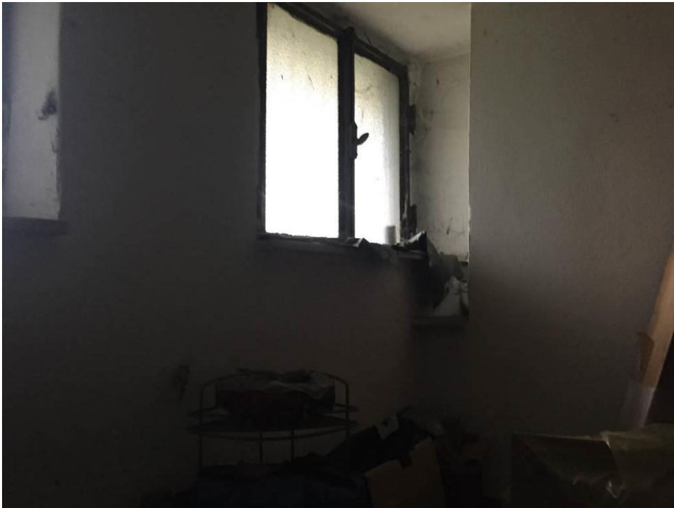
Fotografia n. 18 – Particolare del serramento che risulta in posizione differente rispetto al progetto
