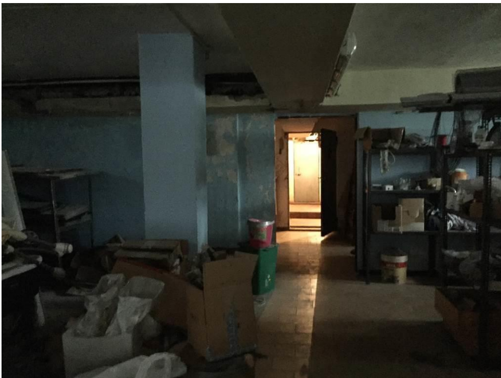
Fotografia n. 14 – Vista del laboratorio, verso la porta di ingresso, e degli impianti ribassati presenti a soffitto
