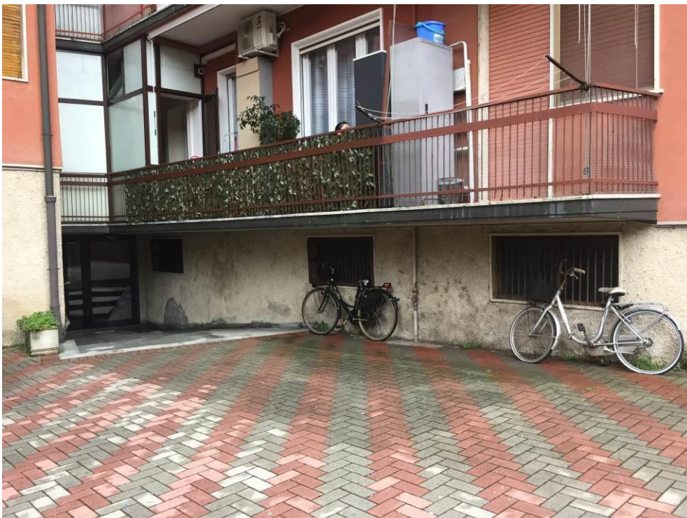
Fotografia n. 4 – Particolare dei serramenti con grata (piano seminterrato) dell'immobile di proprietà dell'esecutato – lato ovest che affacciano sul cortile e sulla rampa di accesso al fabbricato
