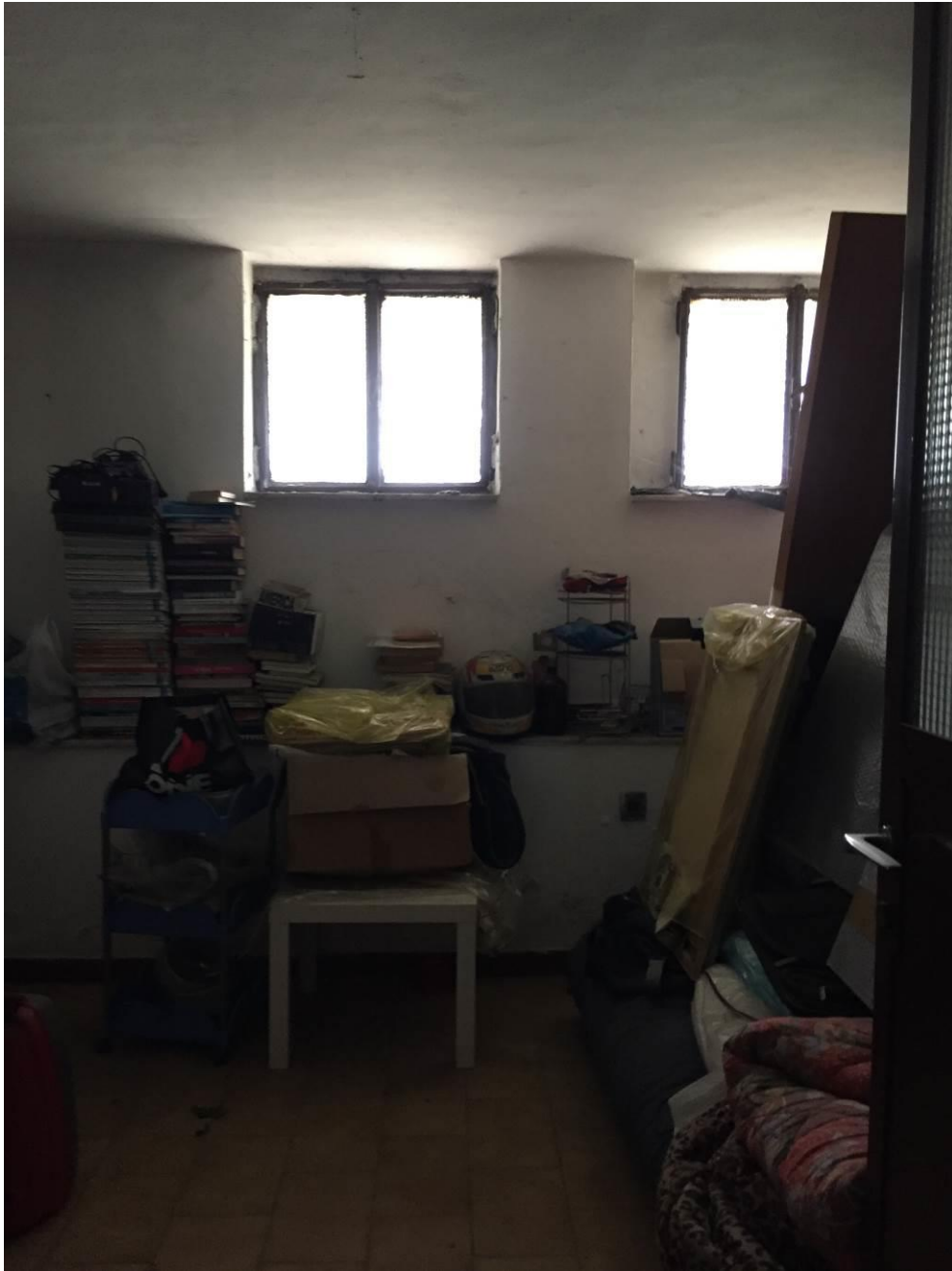
Fotografia n. 17 – Vista del locale ufficio – lato est con serramenti che affacciano sulla Via Virgilio, di cui uno risulta in posizione differente rispetto al progetto
