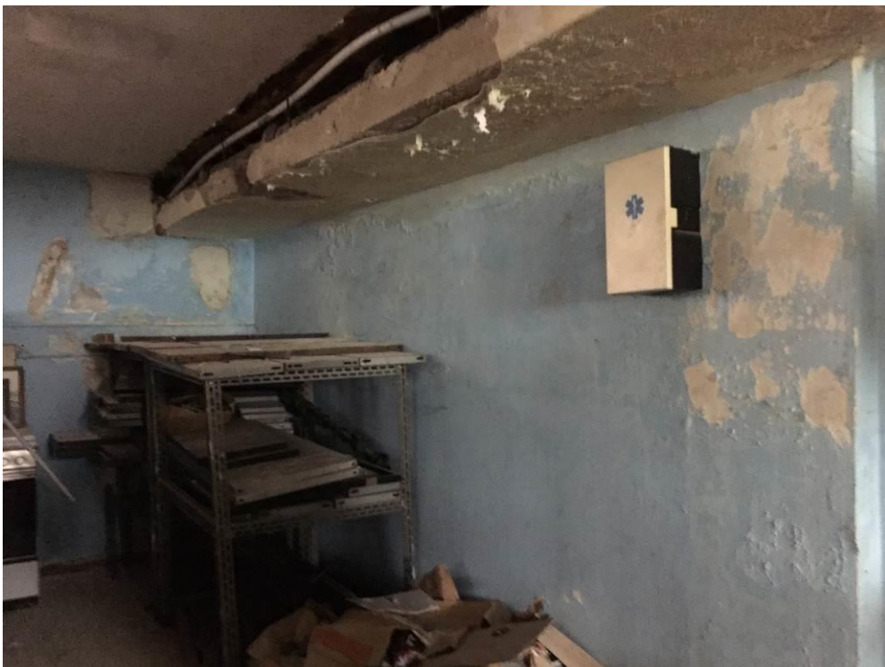
Fotografie n. 19 – Vista del laboratorio – lato ovest con particolare degli impianti ribassati a soffitto e delle macchie di umidità
