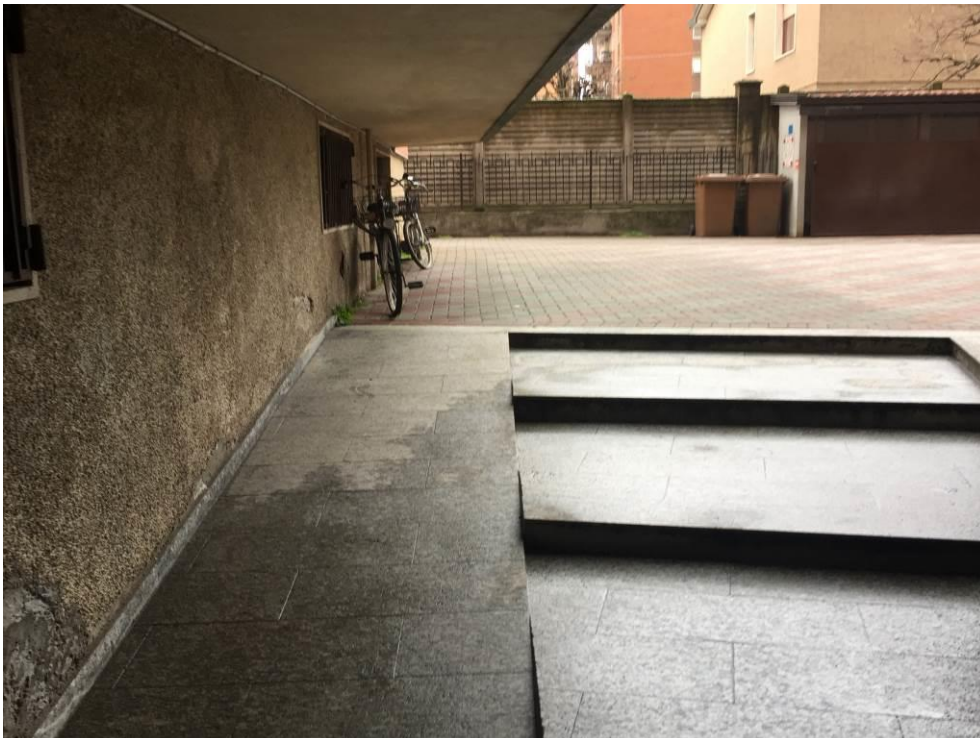
Fotografia n. 6 – Particolare della rampa e dello scalone, che conducono al portone di ingresso al piano seminterrato del fabbricato, dove si trovano i beni immobili di proprietà dell'esecutato
