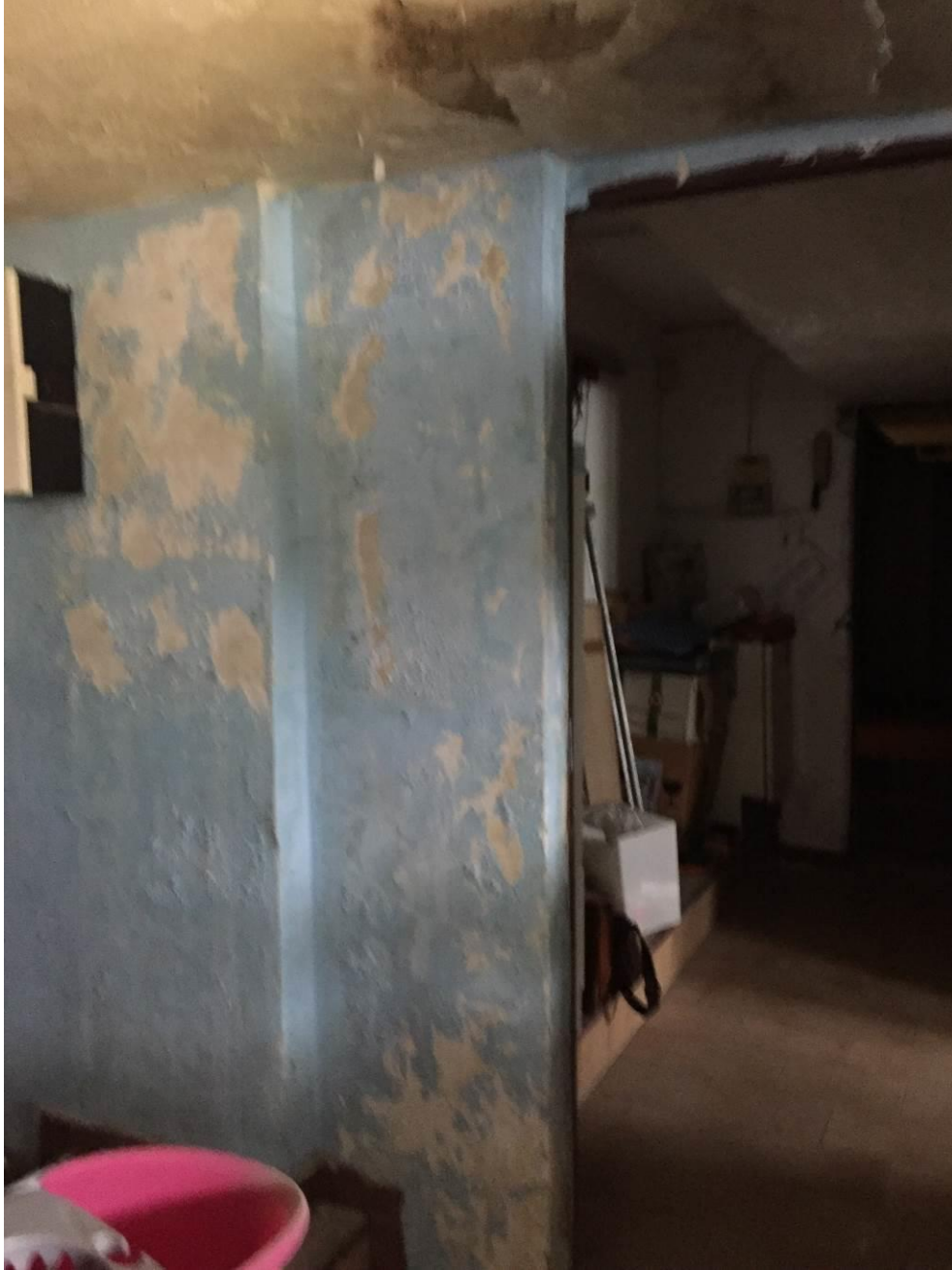
Fotografia n. 15 – Vista della parete del laboratorio, verso il locale ingresso, con presenza di umidità da risalita, con particolare del gradino (trave rovescia) a pavimento di altezza cm. 20 c.ca che attraversa l'immobile
