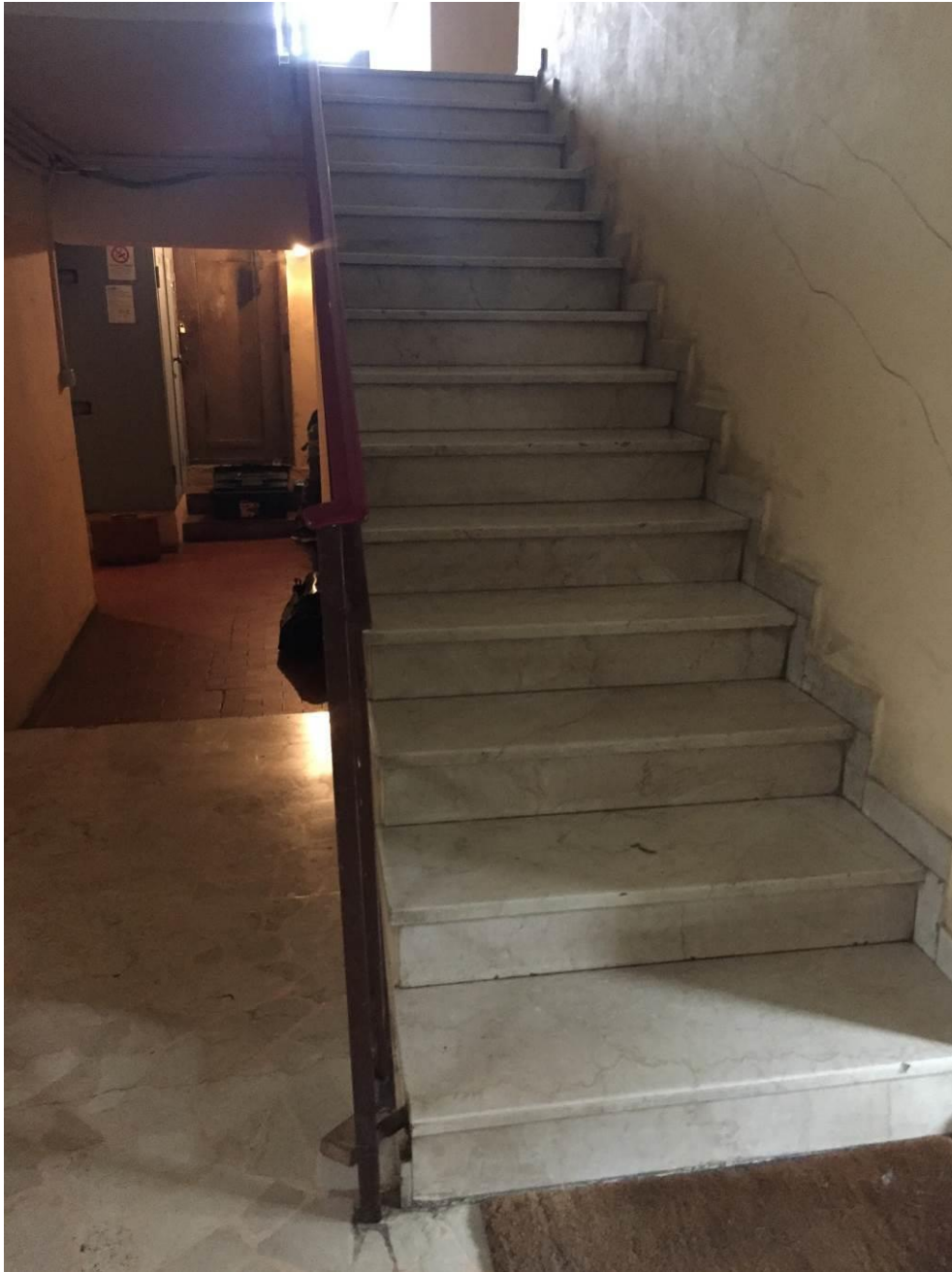
Fotografia n. 10 – Vista della rampa di scale che conduce sia al piano rialzato sia al piano seminterrato, dove sono presenti gli immobili di proprietà dell'esecutato
