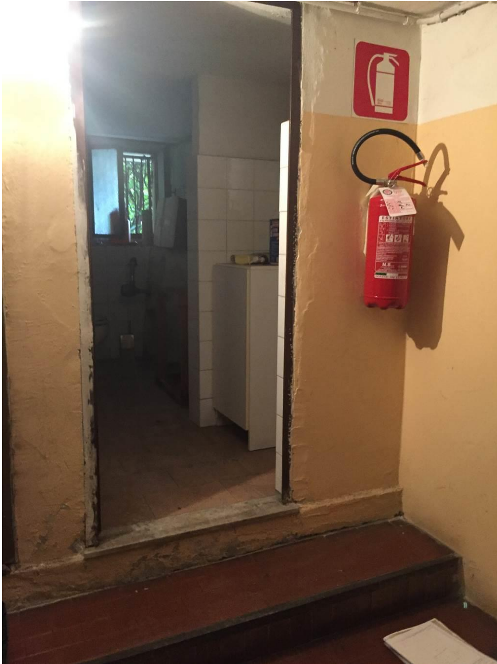
Fotografia n. 24 – Vista, dal corridoio comune del piano seminterrato, dell'accesso al locale bagno esterno, attiguo ai locali laboratorio, di proprietà dell'esecutato
