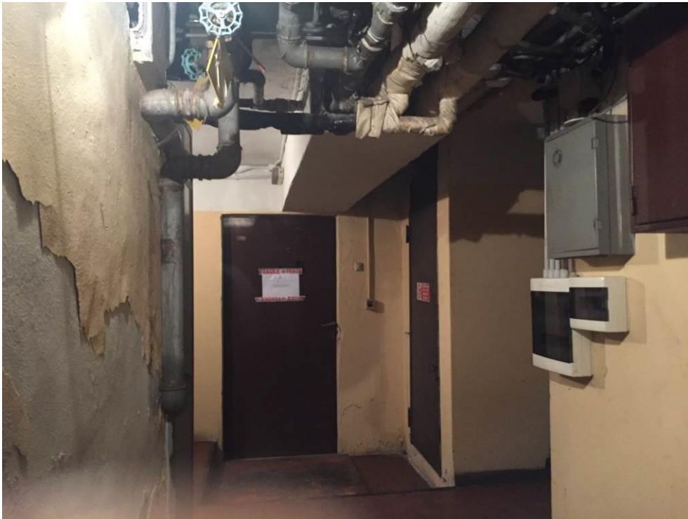
Fotografia n. 13 – Vista di fronte dell'accesso ai locali laboratorio (piano seminterrato), di proprietà dell'esecutato, e degli impianti a soffitto che attraversano i suddetti locali
