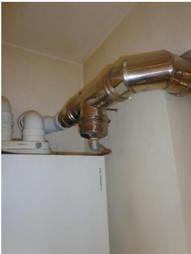
Particolari delle tubature, relative alla caldaia autonoma, passanti all'interno della ex canna fumaria condominiale; installazione di termoconvettori relativi all'impianto di riscaldamento a gas metano.
