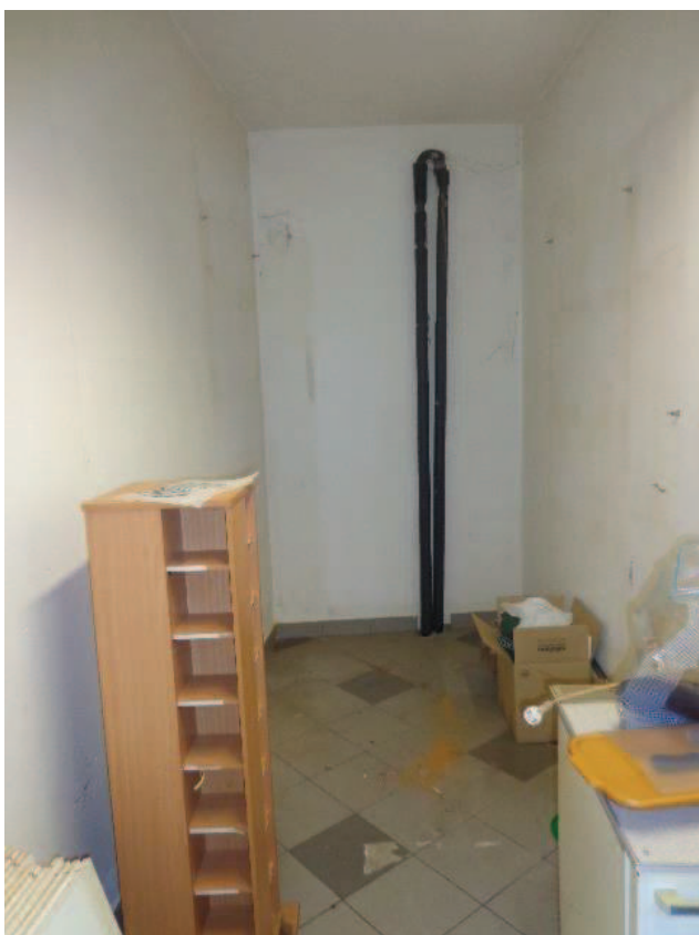
Particolari di alcune tubature relative al vecchio impianto di riscaldamento centralizzato dismesso.
