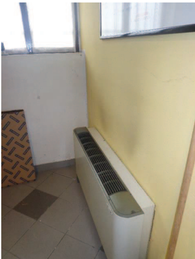
Particolari del secondo termoconvettore installato e di alcune infiltrazioni d'acqua, con esfoliazioni d'intonaco e macchie di muffa, rilevate sulla parete lato sud / est; pavimentazioni e battiscopa in monocottura.
