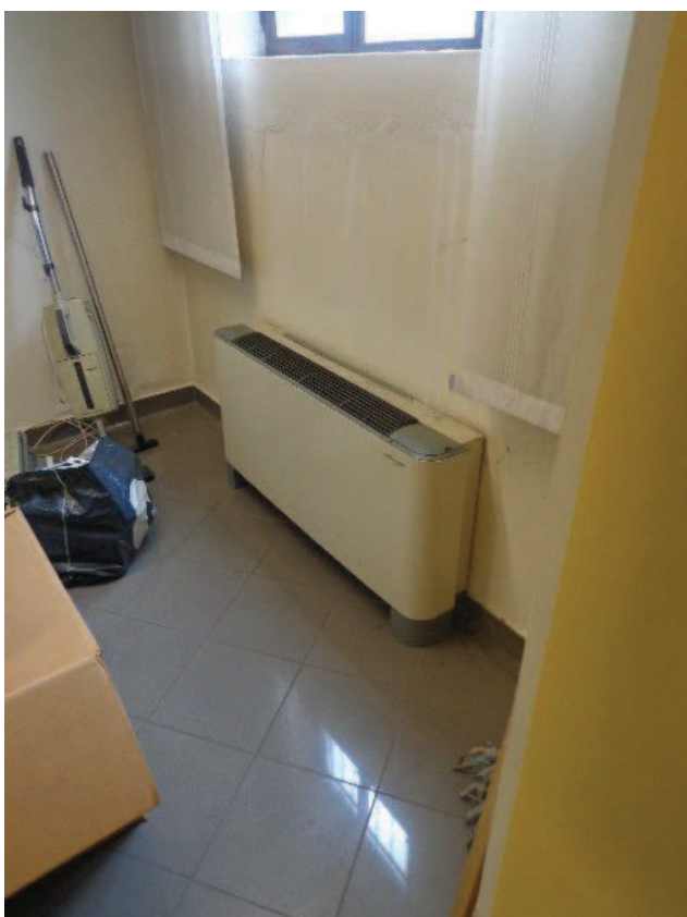
Particolari dei termoconvettori installati nello spazio sul lato nord e nello spazio centrale dell'immobile attualmente occupato da materiale promiscuo; presenza di infissi esterni metallici con vetri semplici.
