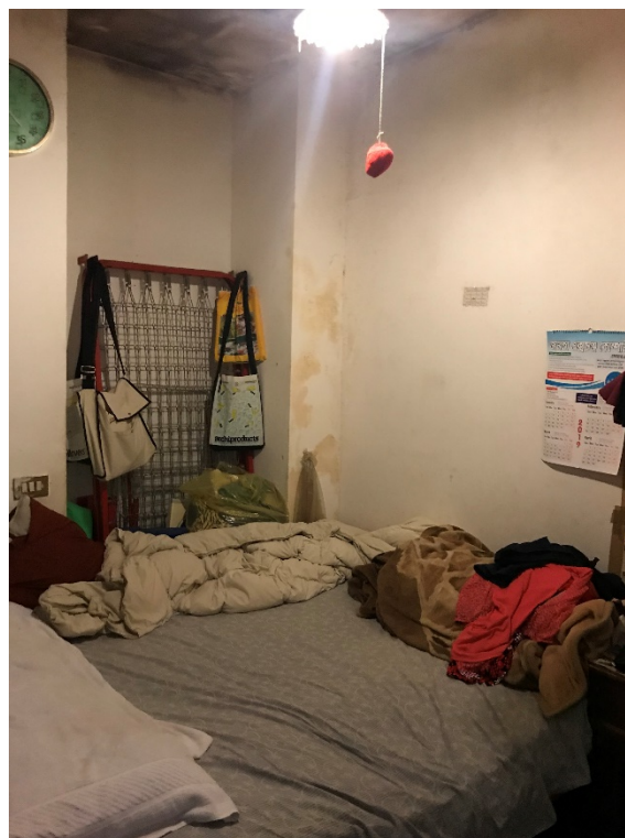
Foto n. 6: Ripostiglio adibito a camera
