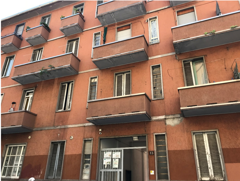
Foto n. 1: Prospetto principale su via Arquà.
