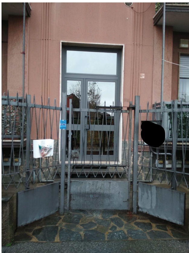
Foto n. 2 – Ingresso al fabbricato
