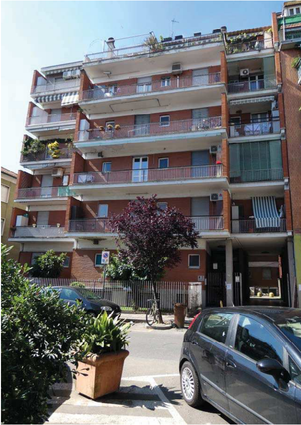
Foto 1: prospetto su Via Gorizia
