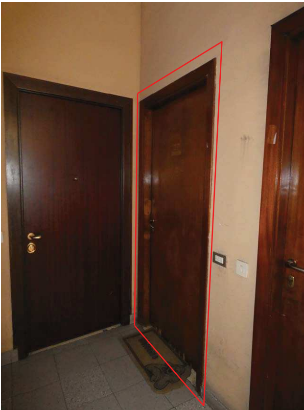
Foto 7: porta d'accesso all'appartamento
