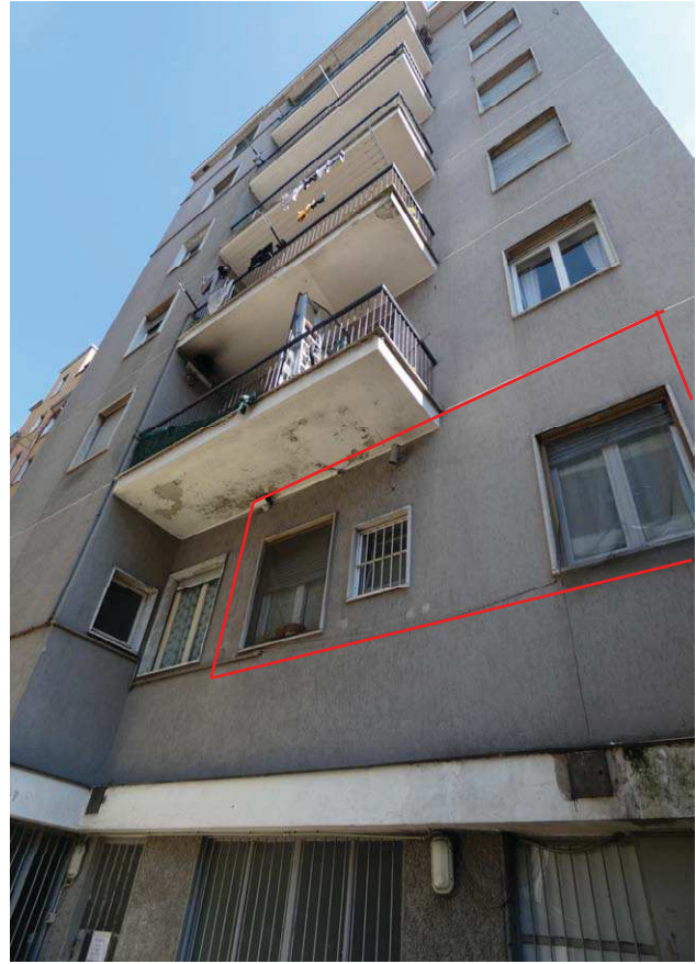
Foto 2: prospetto su cortile
