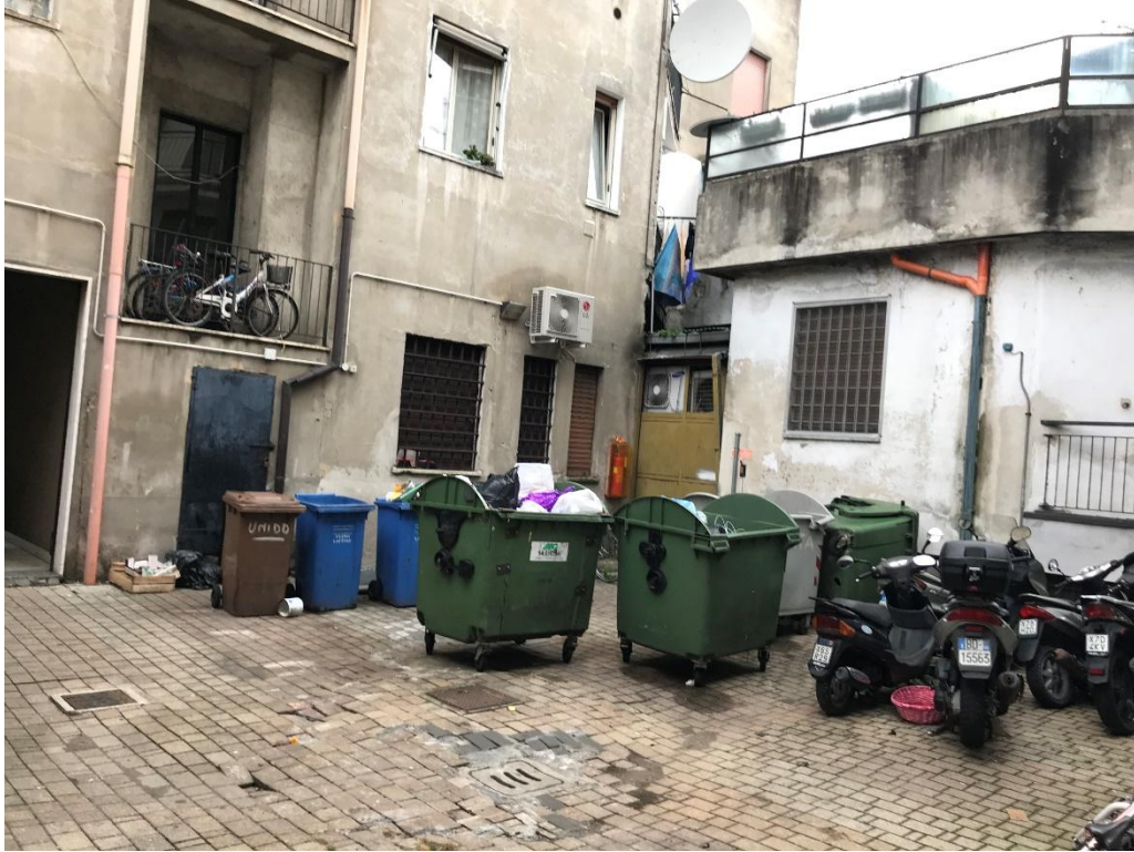
Foto n. 3: Dettaglio cortile interno
