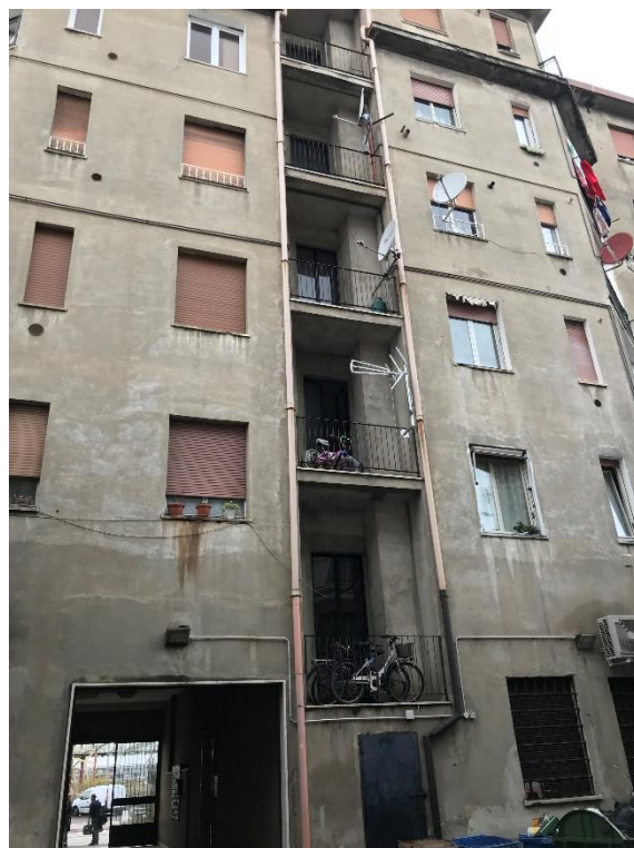
Foto n. 2: Prospetto cortile interno
