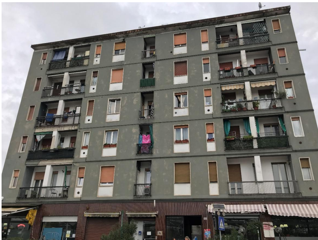
Foto n. 1: Prospetto principale su Via Valera
