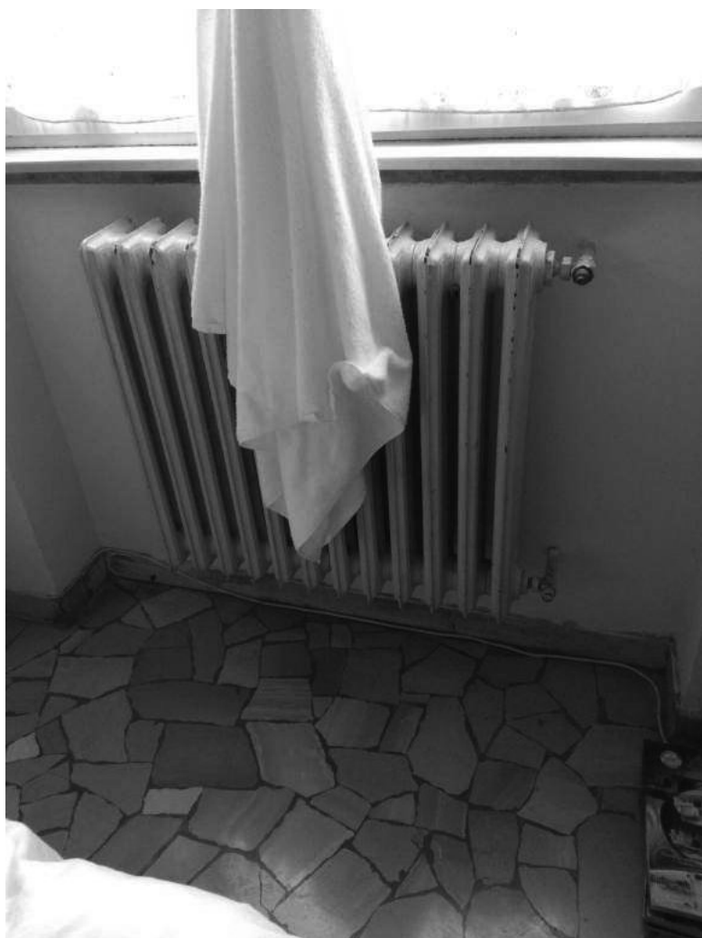
Foto 12,13, 14, 15, 16 – particolari radiatori, finestre, porta entrata e caldaietta murale
