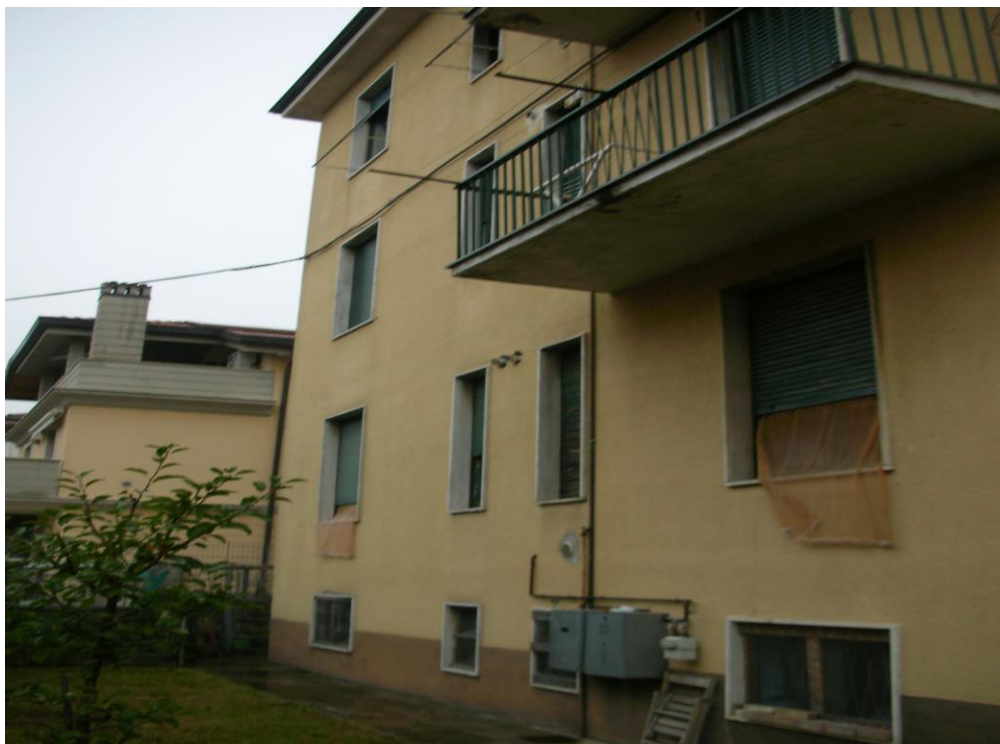
Foto n. 2 – Prospetto retrostante del fabbricato dove si trova il bene pignorato
