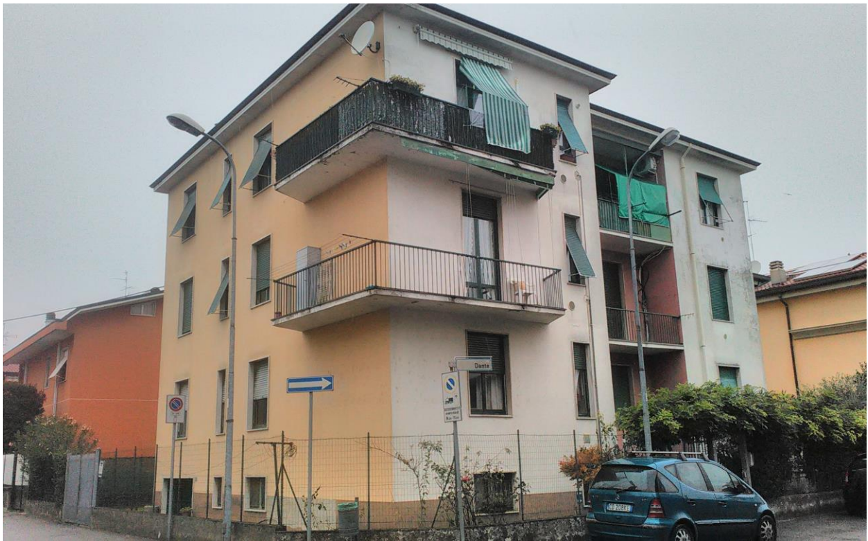
Foto n. 1 – Prospetto frontale del fabbricato dove si trova il bene pignorato
