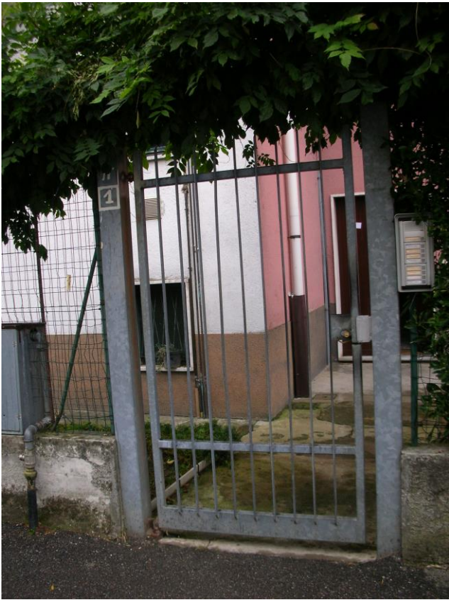
Foto n. 3 – Ingresso al fabbricato
