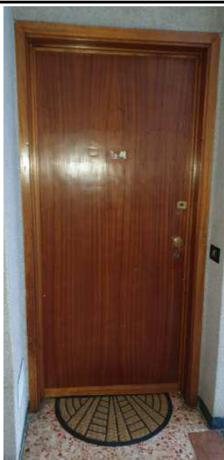
Immobile in via G. Leopardi, 13 Vaprio d'Adda: porta di ingresso all'appartamento pignorato
