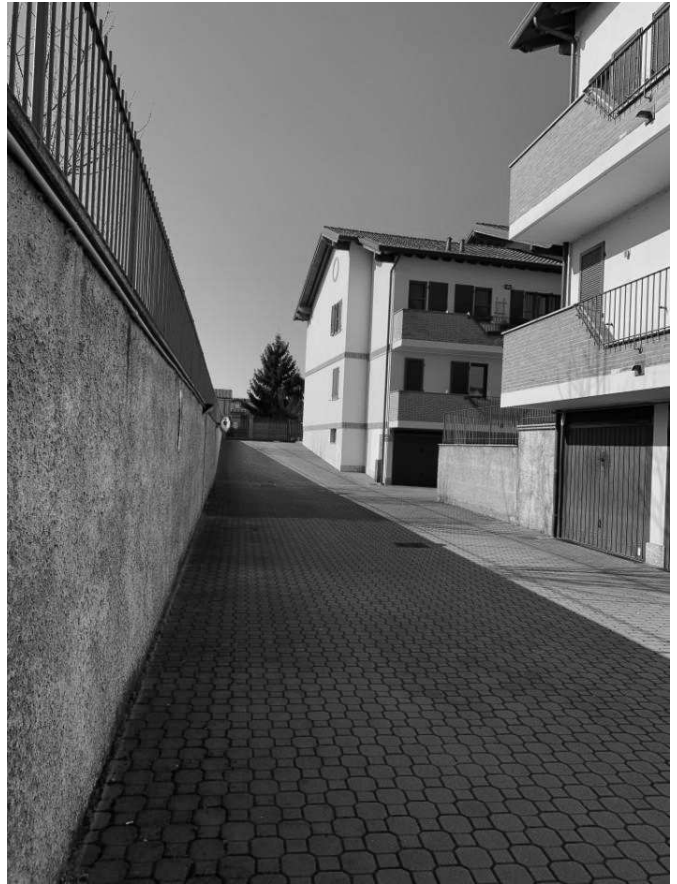
Passo carraio per accedere all'autorimessa
