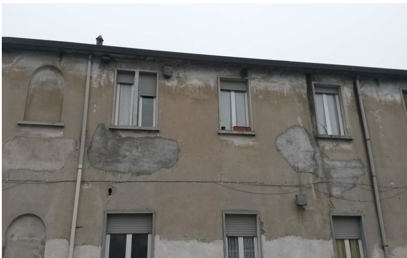
VISTA DALLA STRADA DEL PIANO PRIMO DOVE SITUATA L'UNITA' IMMOBILIARE IN OGGETTO
