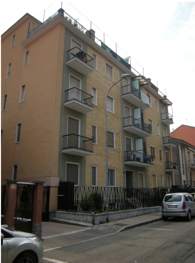
Foto 2 – Altra vista d'insieme dell'edificio.
