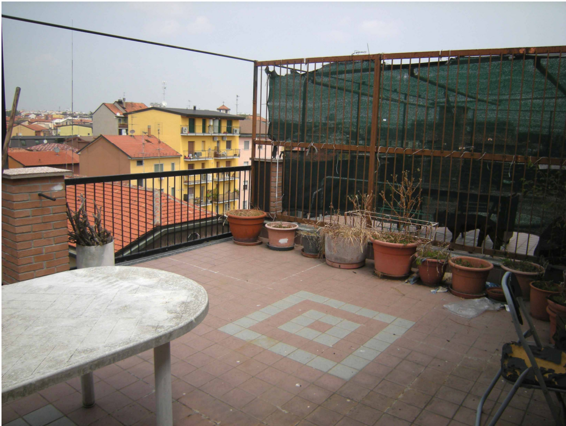
Foto 13 – Vista parziale del terrazzo.
