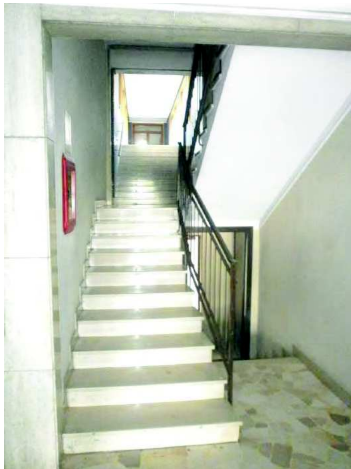
- FOTO 4 - SCALE CONDOMINIALI -
