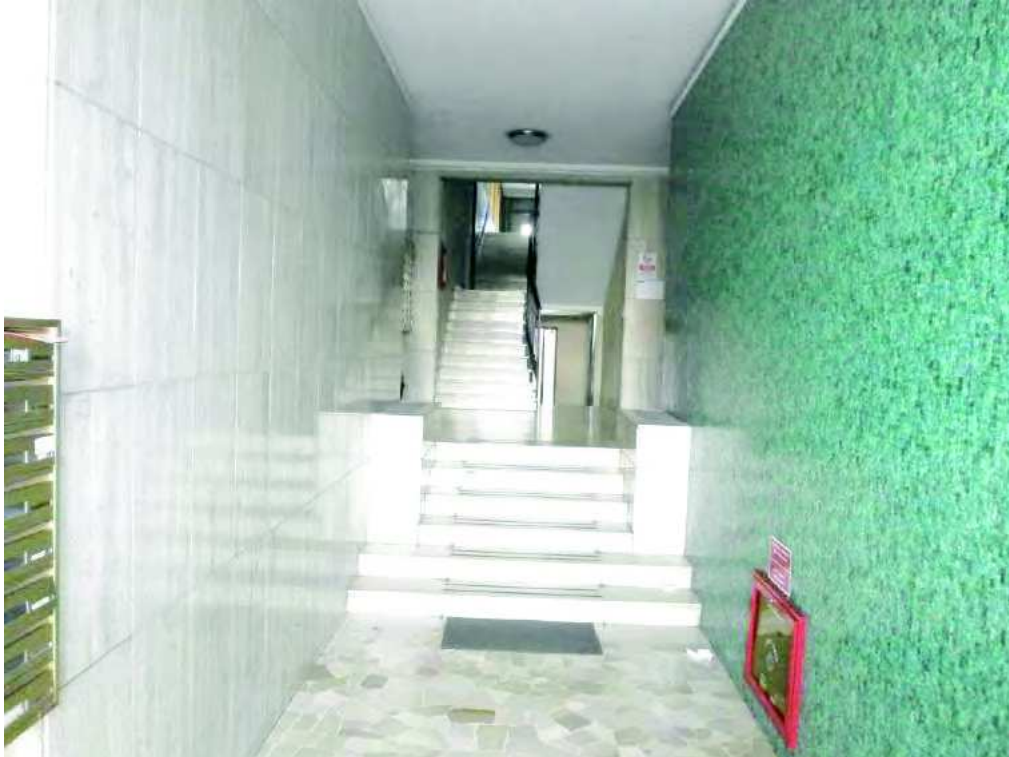
- FOTO 3 - ANDRONE DI INGRESSO -
