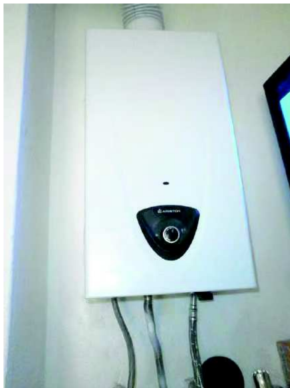
- FOTO 10 - PARTICOLARE SCALDABAGNO -
