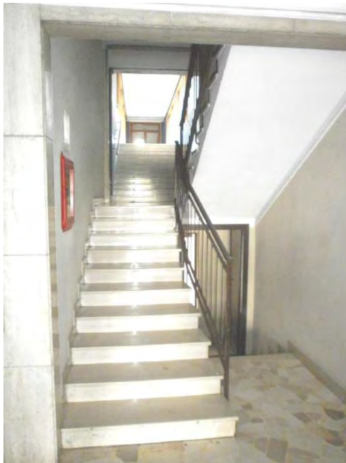
- FOTO 4 - SCALE CONDOMINIALI -
