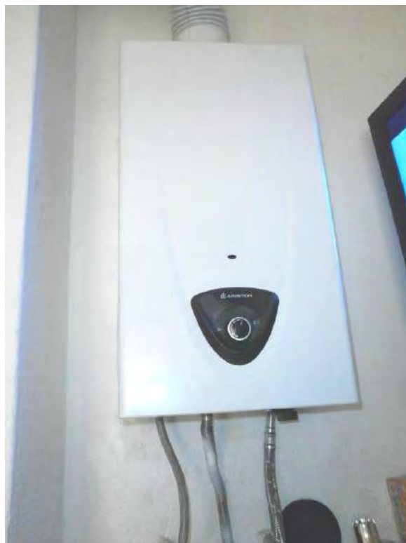
- FOTO 10 - PARTICOLARE SCALDABAGNO -
