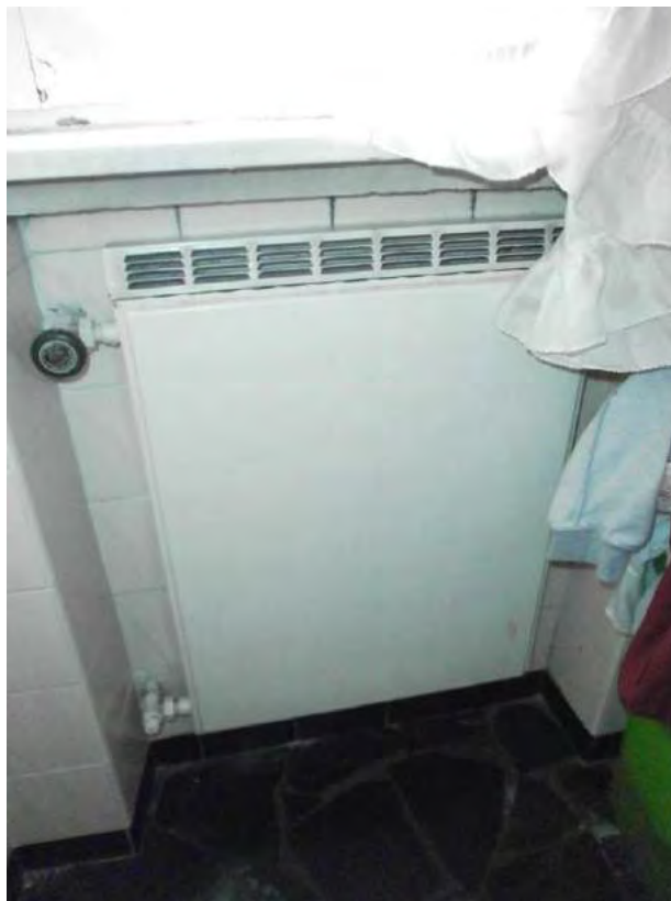
- FOTO 12 - PARTICOLARE TERMOSIFONI IN ALLUMINIO -
