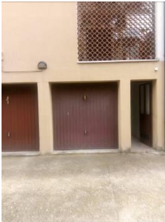
Ingresso locale box
