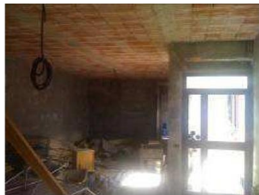
Foto 31: laboratorio in ristrutturazione
