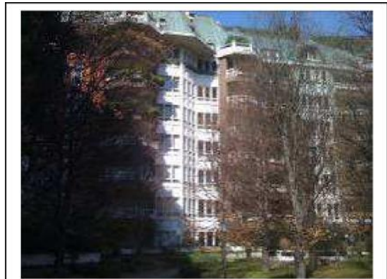
Foto 13: l'immobile dalla corte interna
