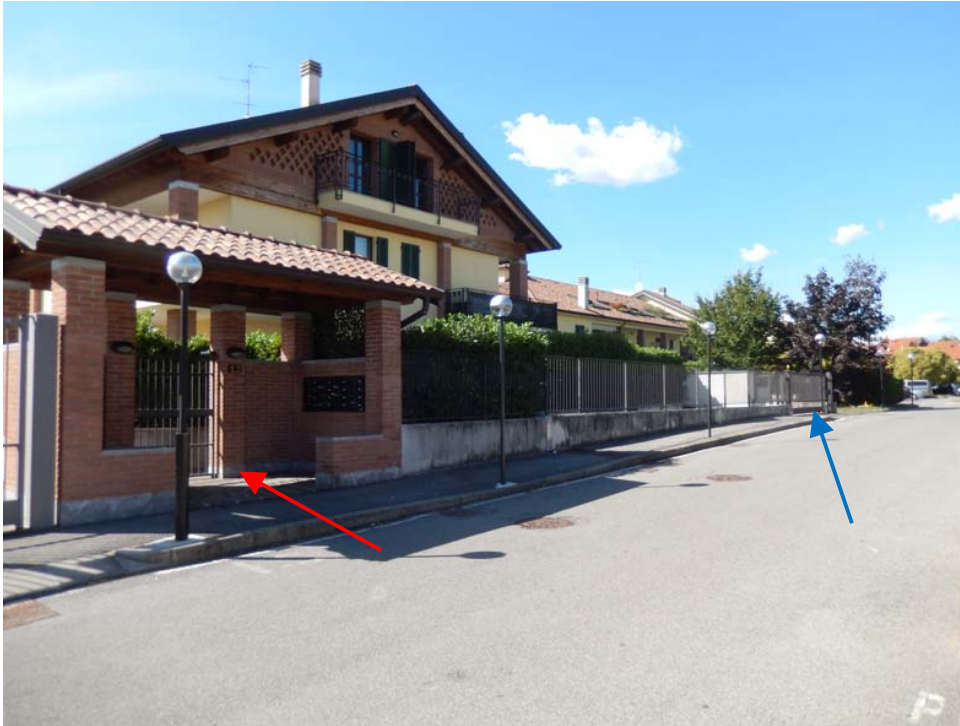
FOTO 5: Vista degli ingressi pedonale (freccia rossa) e carraio (freccia blu) al complesso condominiale di cui è parte l'unità pignorata. Gli ingressi non sono posti su Via Repubblica, bensì su Via Giacomo Matteotti, al civico n° 12.
