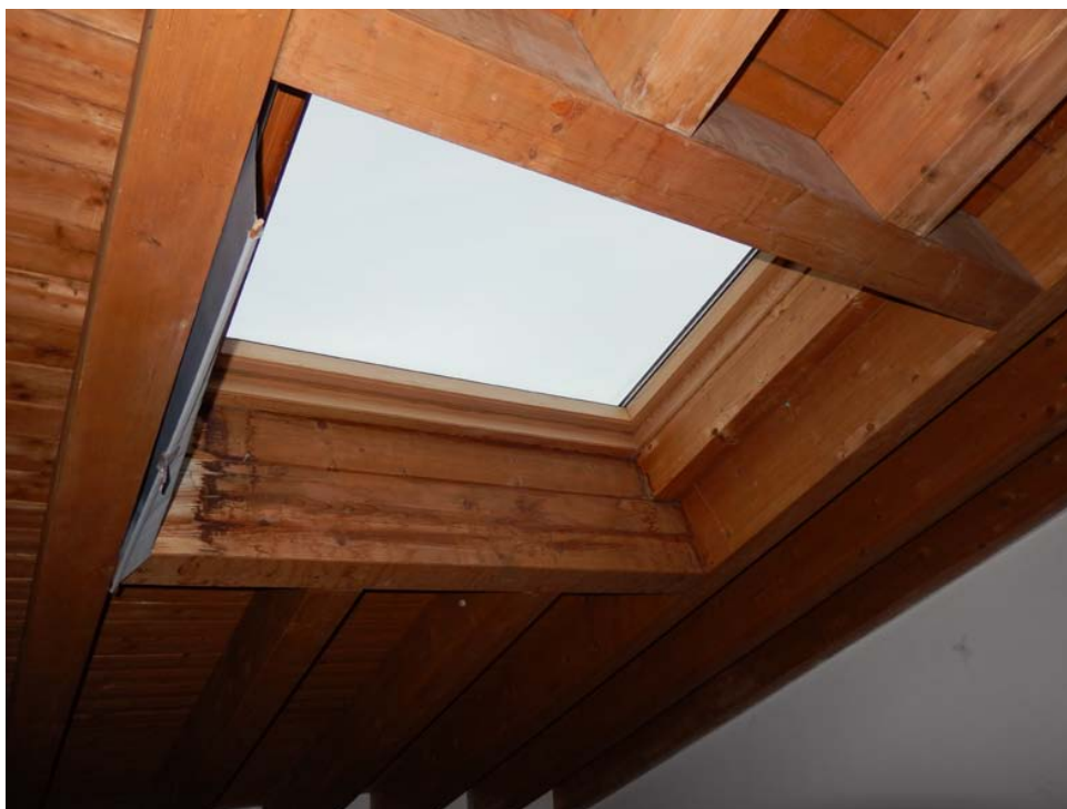
FOTO 27: Interno dell'unità pignorata – Dettaglio di uno dei lucernari Velux.
