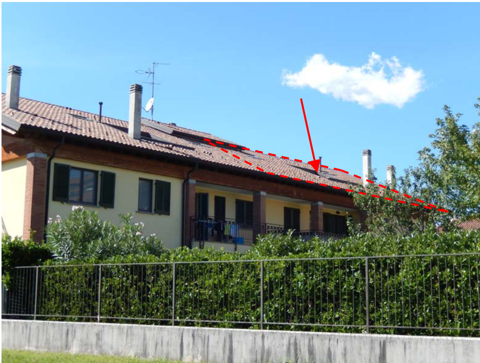
FOTO 2: Vista di maggior dettaglio della posizione dell'unità pignorata, evidenziata dal poligono rosso, di cui si intravede il terrazzo (nascosto dalla falda di copertura) indicato dalla freccia rossa.
