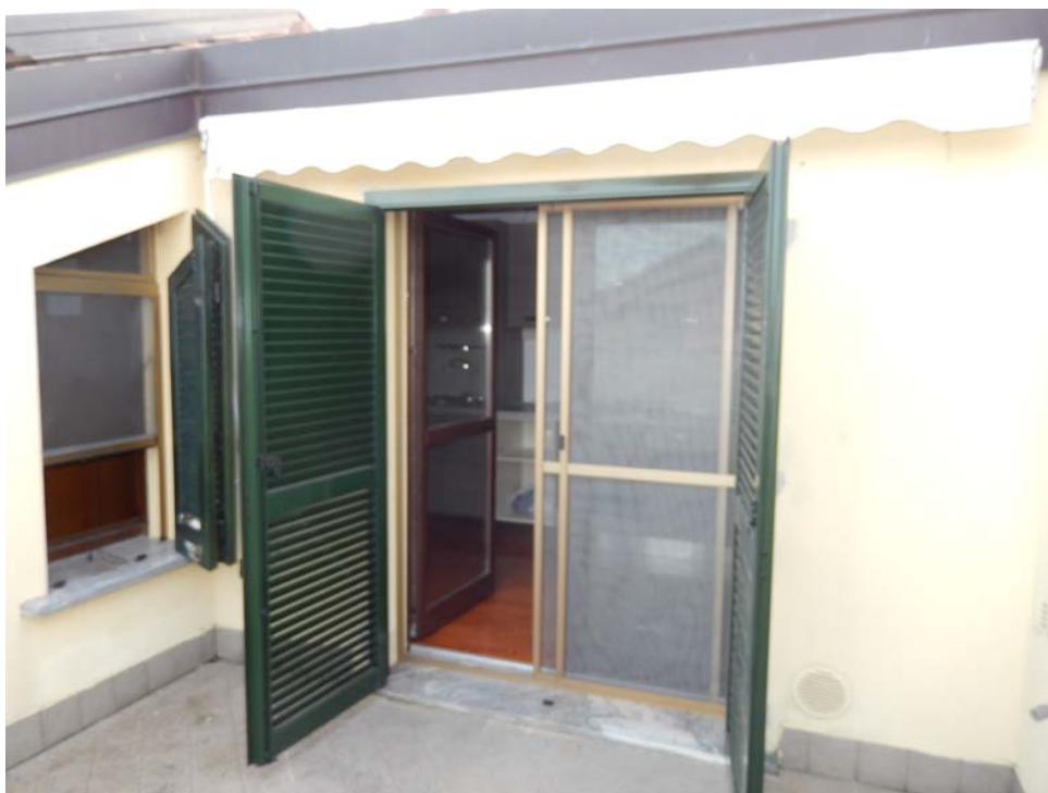
FOTO 24: Esterno dell'unità pignorata – Ulteriore scorcio del terrazzo.
