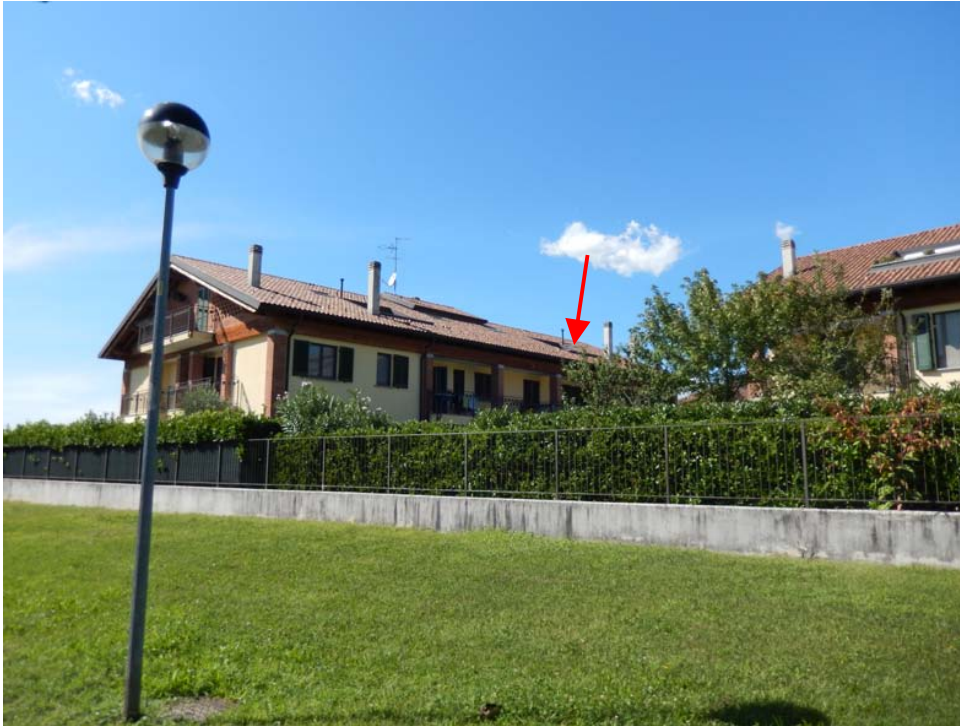
FOTO 1: Vista, dalla Via Angelo Motta, del fabbricato di cui è parte l'unità pignorata, la cui posizione, non affacciando su strada, è indicata dalla freccia rossa.
