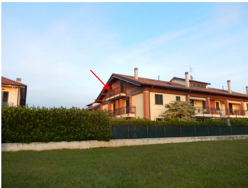
FOTO 3: Vista del fabbricato in cui è sita l'unità pignorata dal prato ubicato ad occidente dell'edificio (corrispondente ai mappali 721 e 722). La posizione dell'immobile in esame è indicata dalla freccia.
