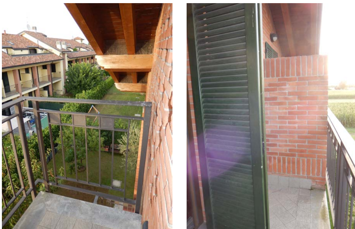
FOTO 21 e 22: Esterno dell'unità pignorata – Scorci del balcone a servizio della camera.
