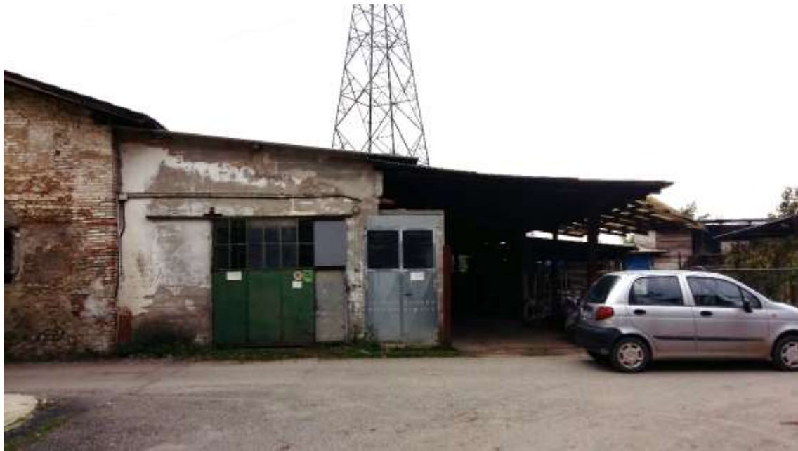
Viste costruzioni al mappale 185
