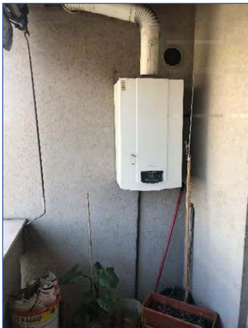
Foto 21 - dettaglio caldaia su balcone
