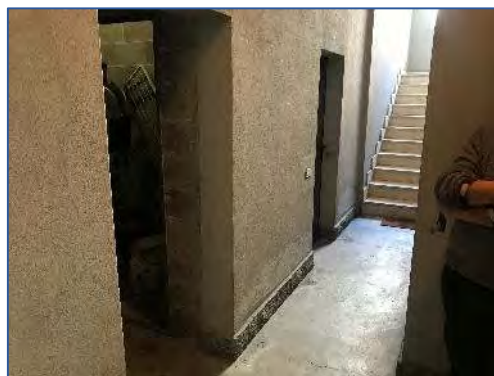
Foto 36 - corridoio comune piano S1
