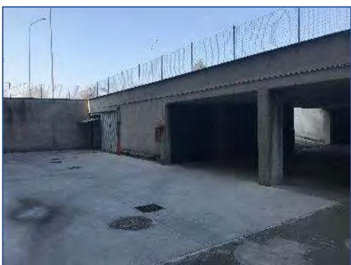
Foto 39 - spazi di manovra comune
