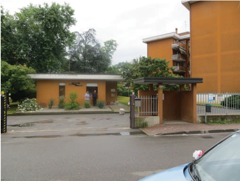
Foto 17 – Ingresso al complesso immobiliare dotato di servizio di portineria
