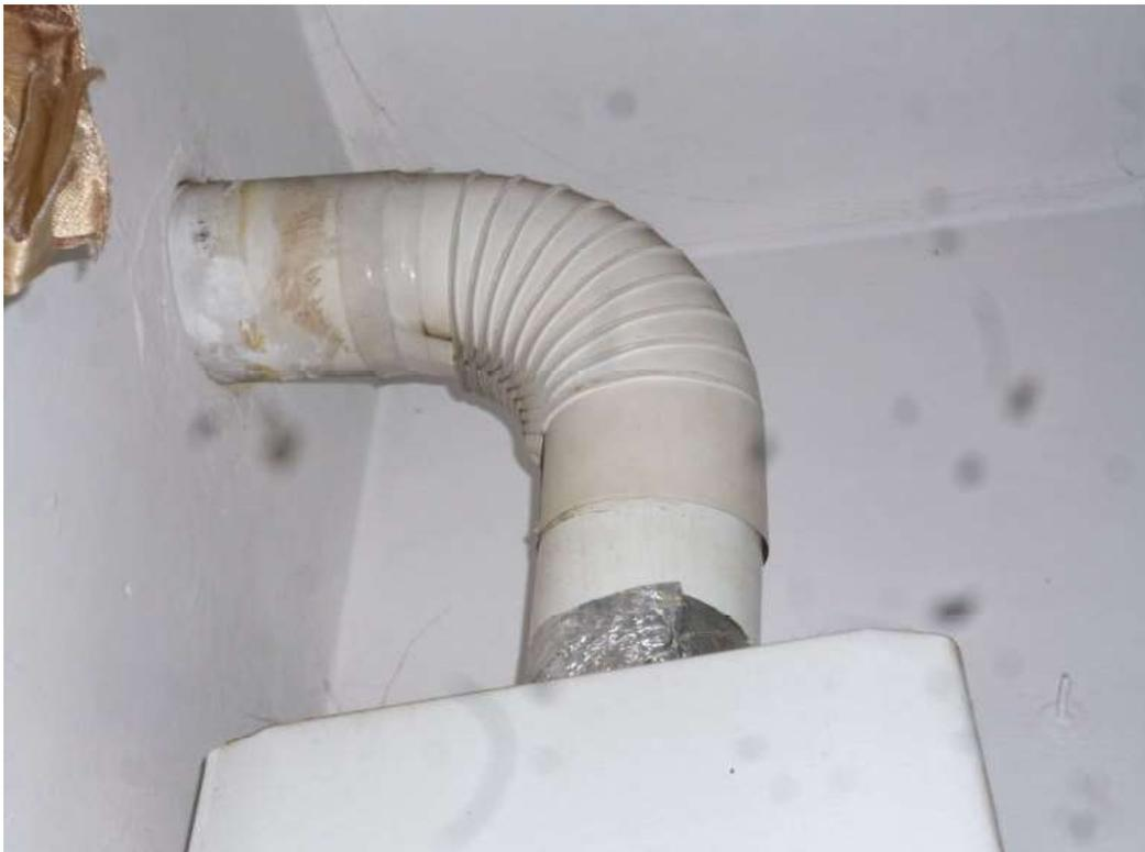
**FOTO 14** – Particolare tubo evacuazione fumi scaldabagno a gas
