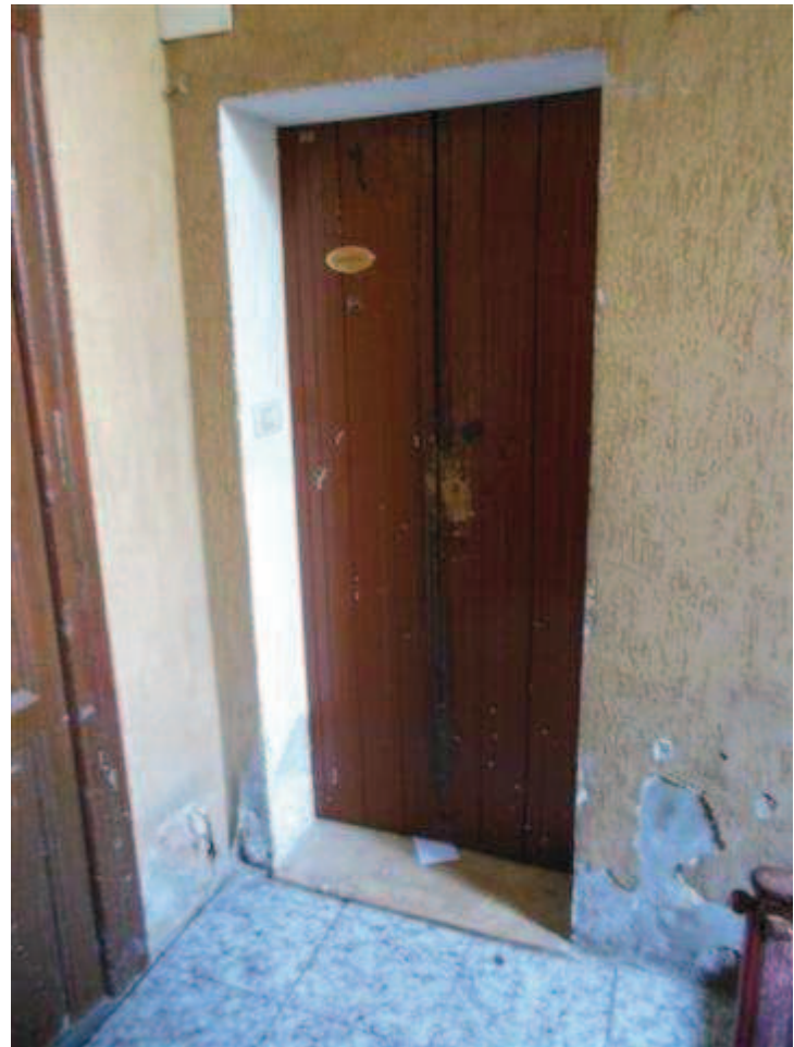
Porta ingresso appartamento
