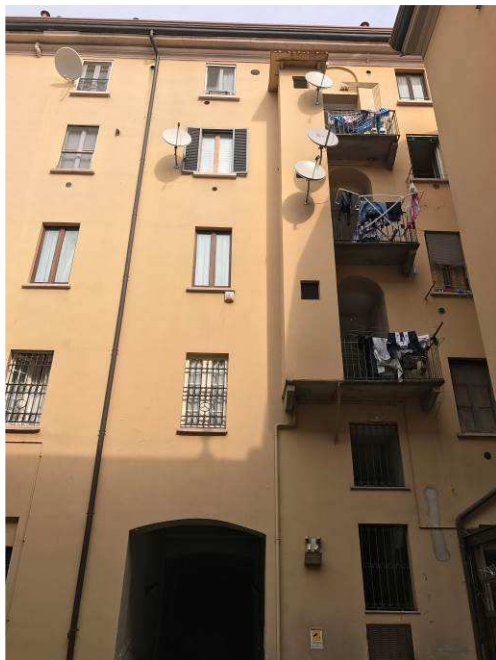
Foto 7 - facciata su corte comune
