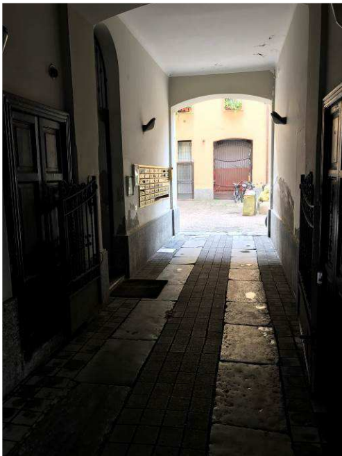
Foto 2 - androne di ingresso
