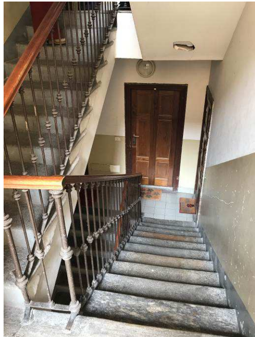
Foto 5 - vano scala comune
